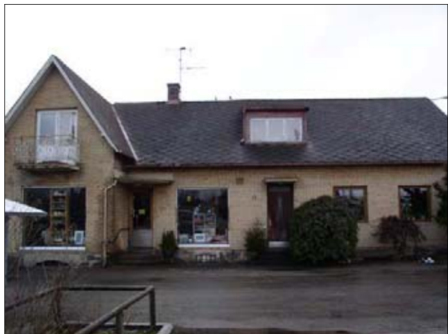
Fig. 11. Norra Rälsgatan, hus 20.
