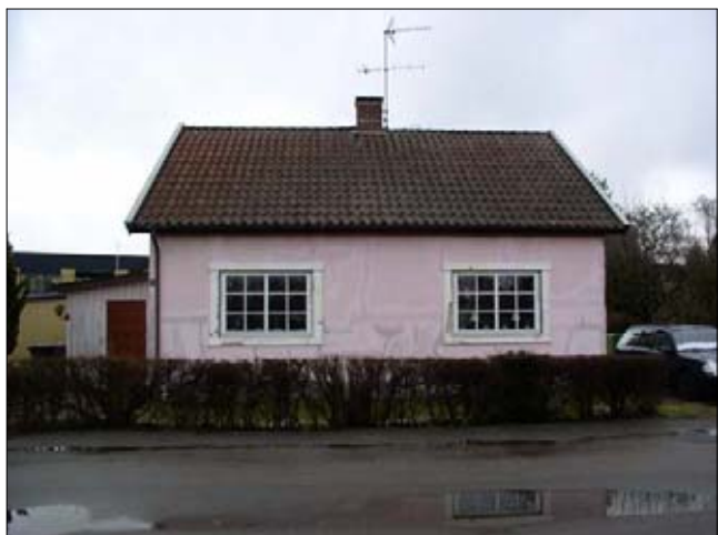
Fig. 12. Norra Rälsgatan, hus 23.
