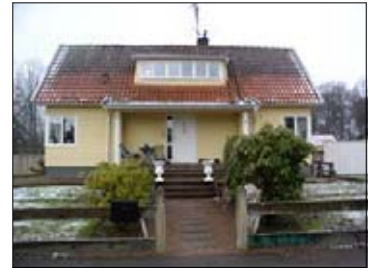
Fig. 5. Äldre villa. Hus 44.
