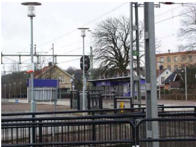
Oversikt mot pågatågsstation.JPG
