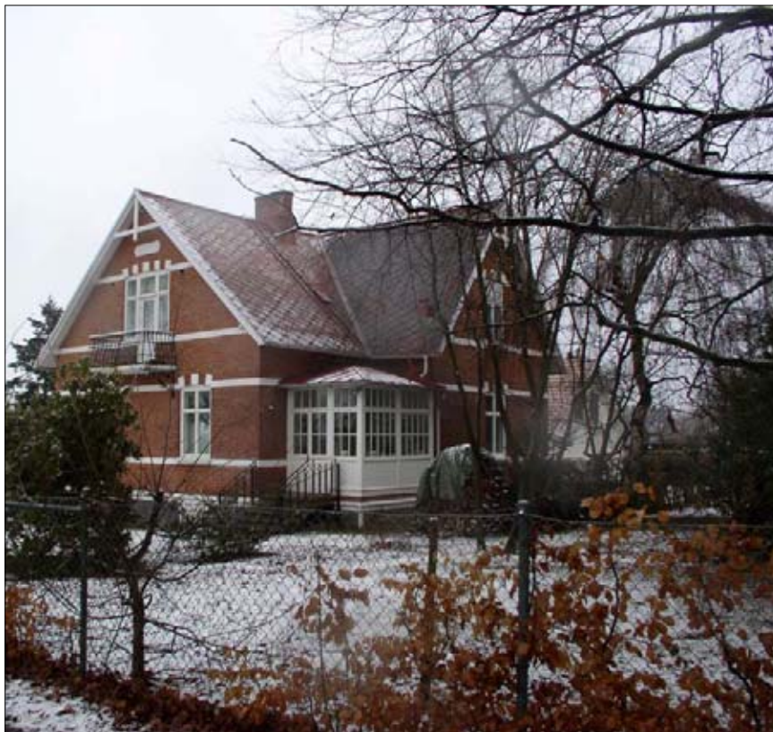
Fig. 10. Södra Rälsgatan, hus 7.
