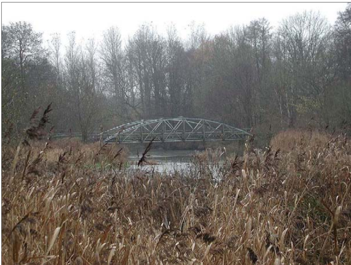
Fig. 10. Den gamla vägbron över Vegeå sedd från järnvägen. Bron berörs inte av korridoren.
