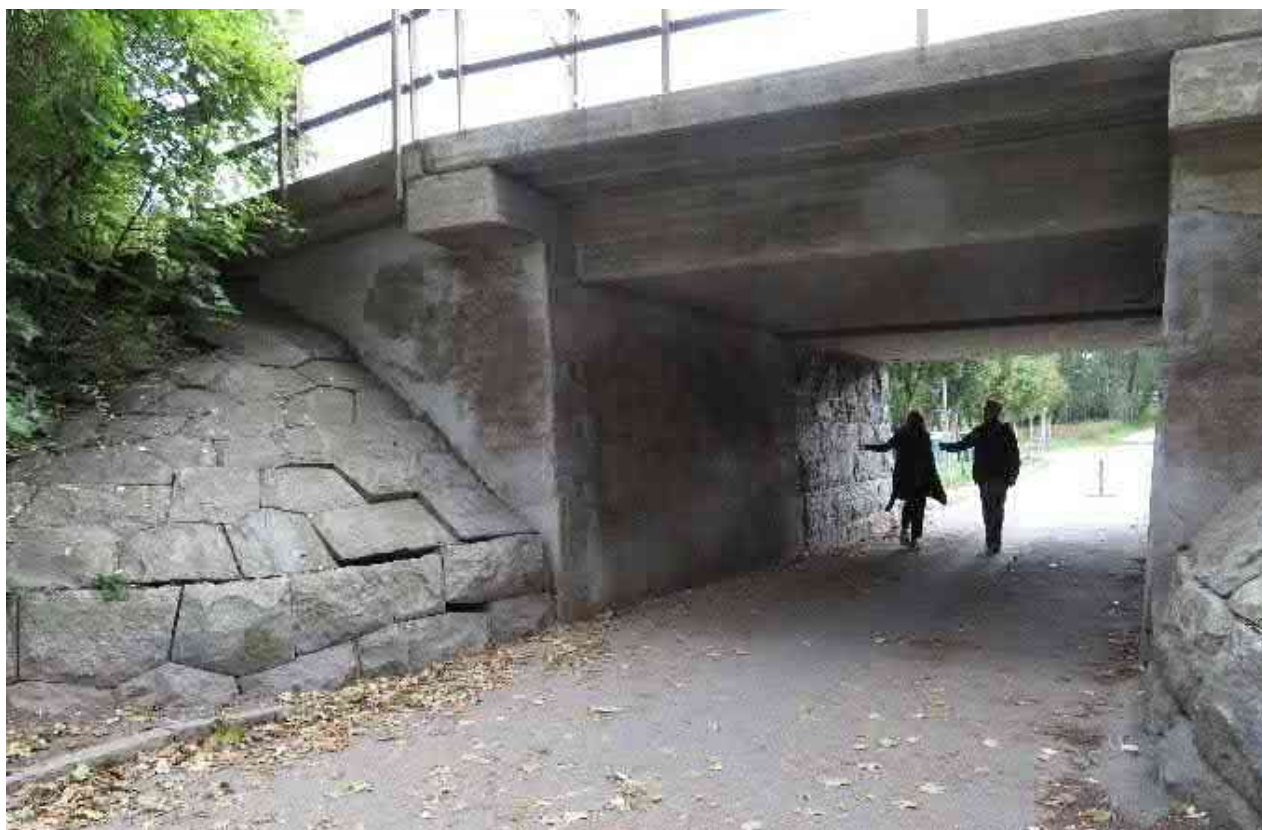
Figur 15. Gång- och cykeltunnel (D) under järnvägen som förbinder Oskarsrogatan med Ankdammsgatan.
