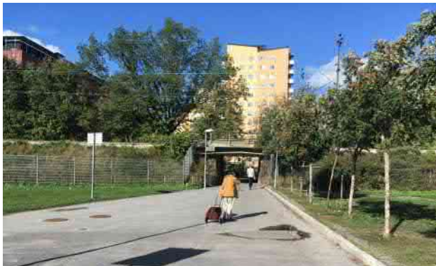
Figur 31. Befintlig gång- och cykeltunnel vid Ankdammsgatan.
