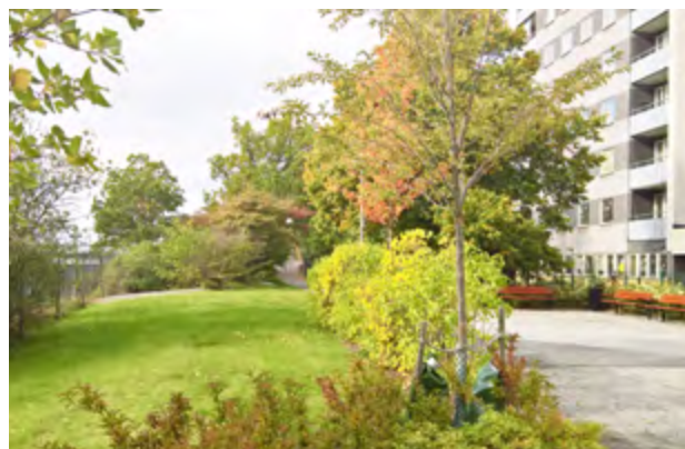
Bostäder mellan spårområdet och Järnvägsgatan
