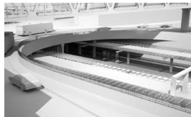
Tråget med betongmur som påkörningsskydd
