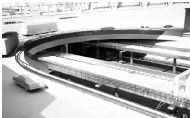
Tråget med navföljare som påkörningsskydd.
