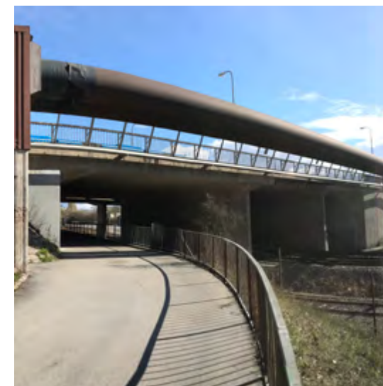
Gång- och cykelbanan under Frösundaledens vägbro
