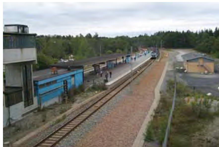
Kallhäll station mot söder.
