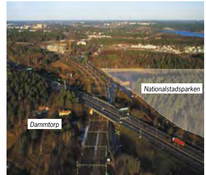
Ostkustbanan norrut. Korsningen med E4 i förgrunden och längre bort Silverdal och Sollentuna. Dammtorps kulturvärde bör beaktas när spårlägen enligt Kista korridor studeras.
