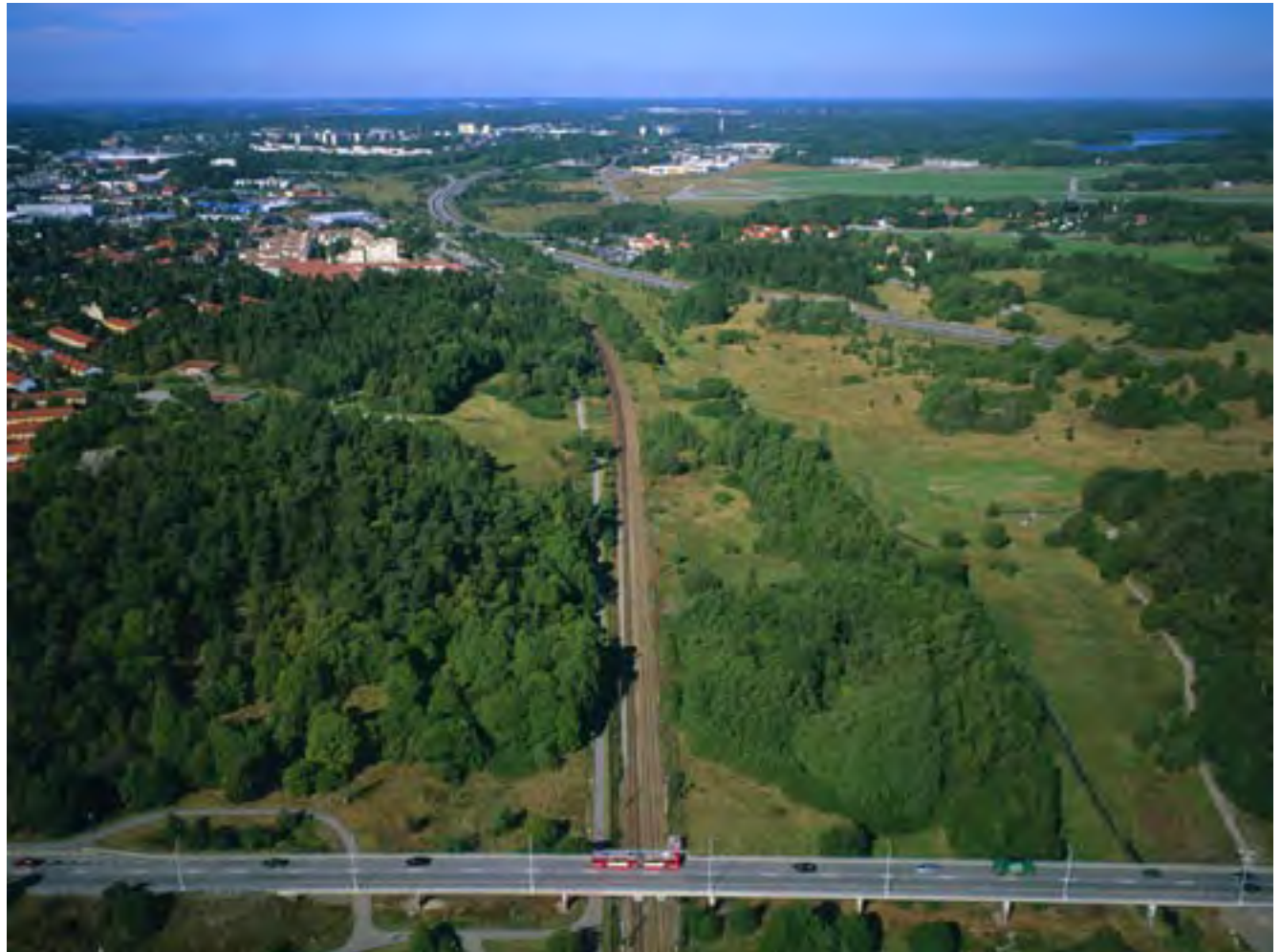
Mälarbanan norrut mot Barkarby station.
