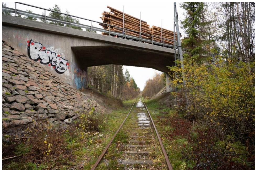
Figur 17 – Bro 21-205-1 som är en bro över järnvägen Dellenbanan.
