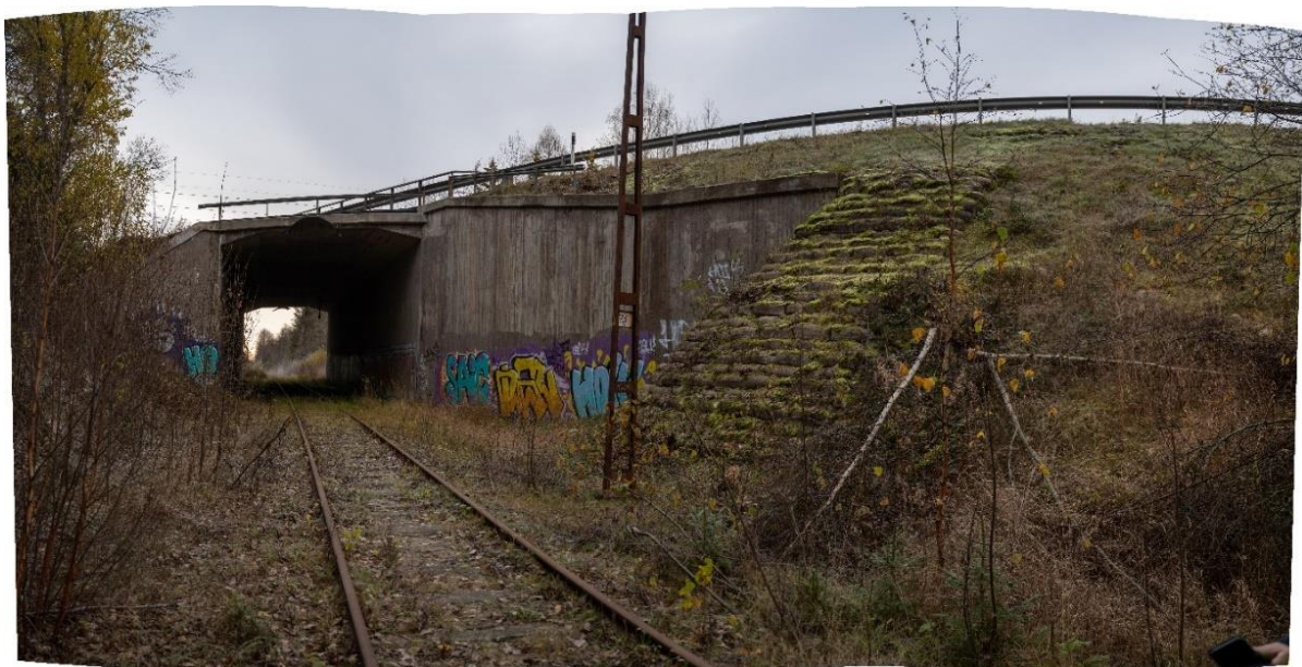
Figur 19 - Bro 21-211-1 som är en bro över järnvägen Dellenbanan.
