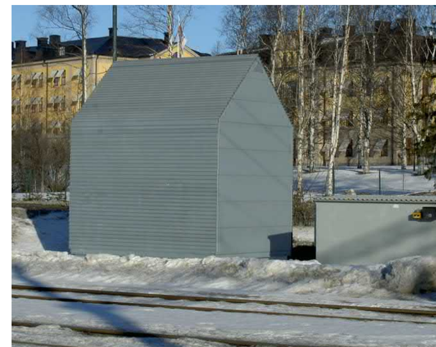
Figur 5.7-2. Foto på mindre teknikhus använt längs Botniabanan. Foto: Trafikverket.
