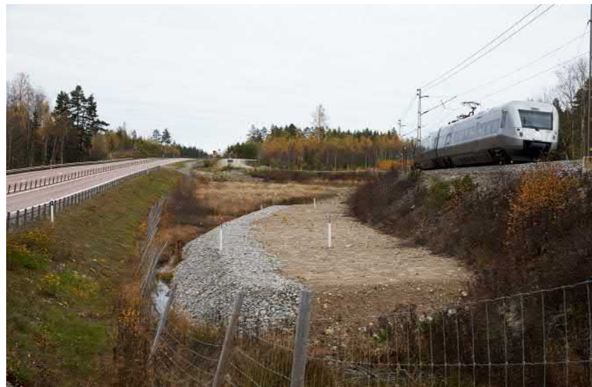
Figur 5.2-1. Exempel på tryckbank utan landskapsanpassning och avsaknad av vegetation. Foto Foto: Publikation Vägbilder, Trafikverket.
