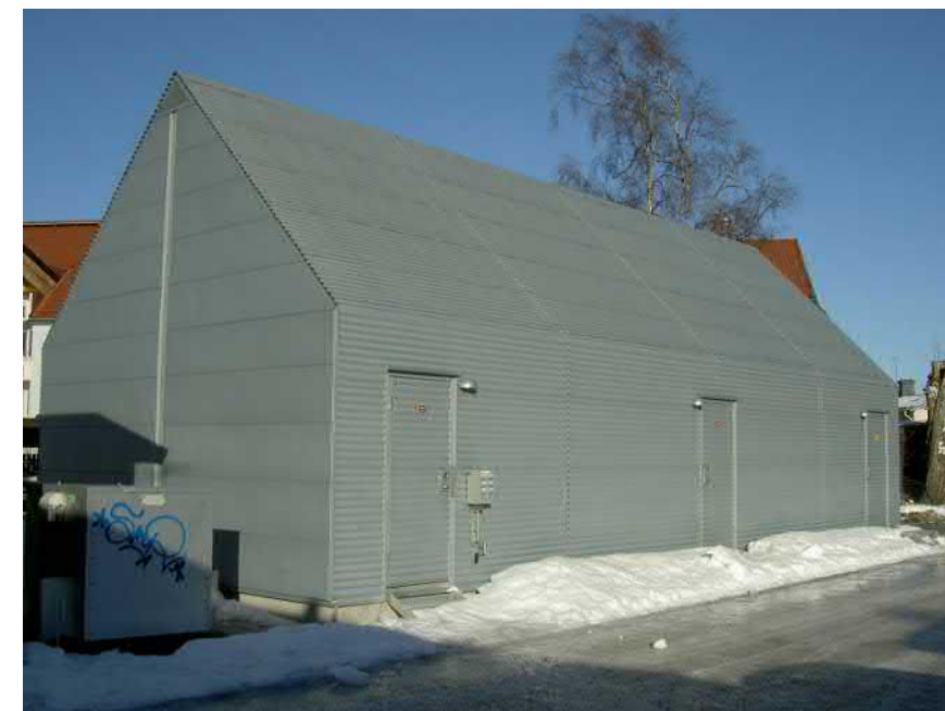
Figur 5.7-1. Foto på större teknikhus använt längs Botniabanan. Foto: Trafikverket.
