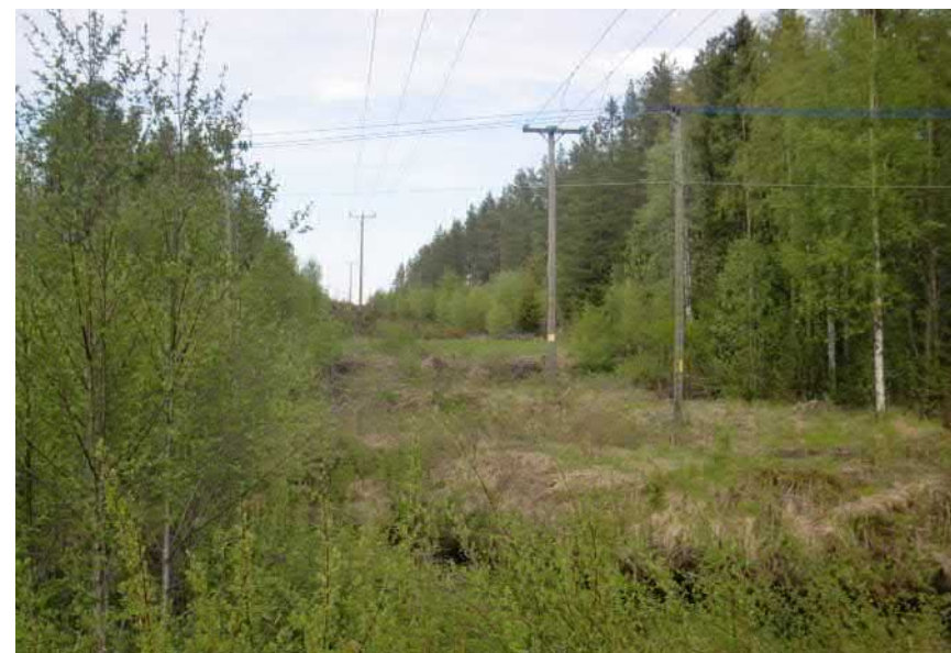
Figur 4.3-2. Foto på kraftledningsgatan som går parallellt med den framtida anläggningen. Foto: WSP Sverige.
