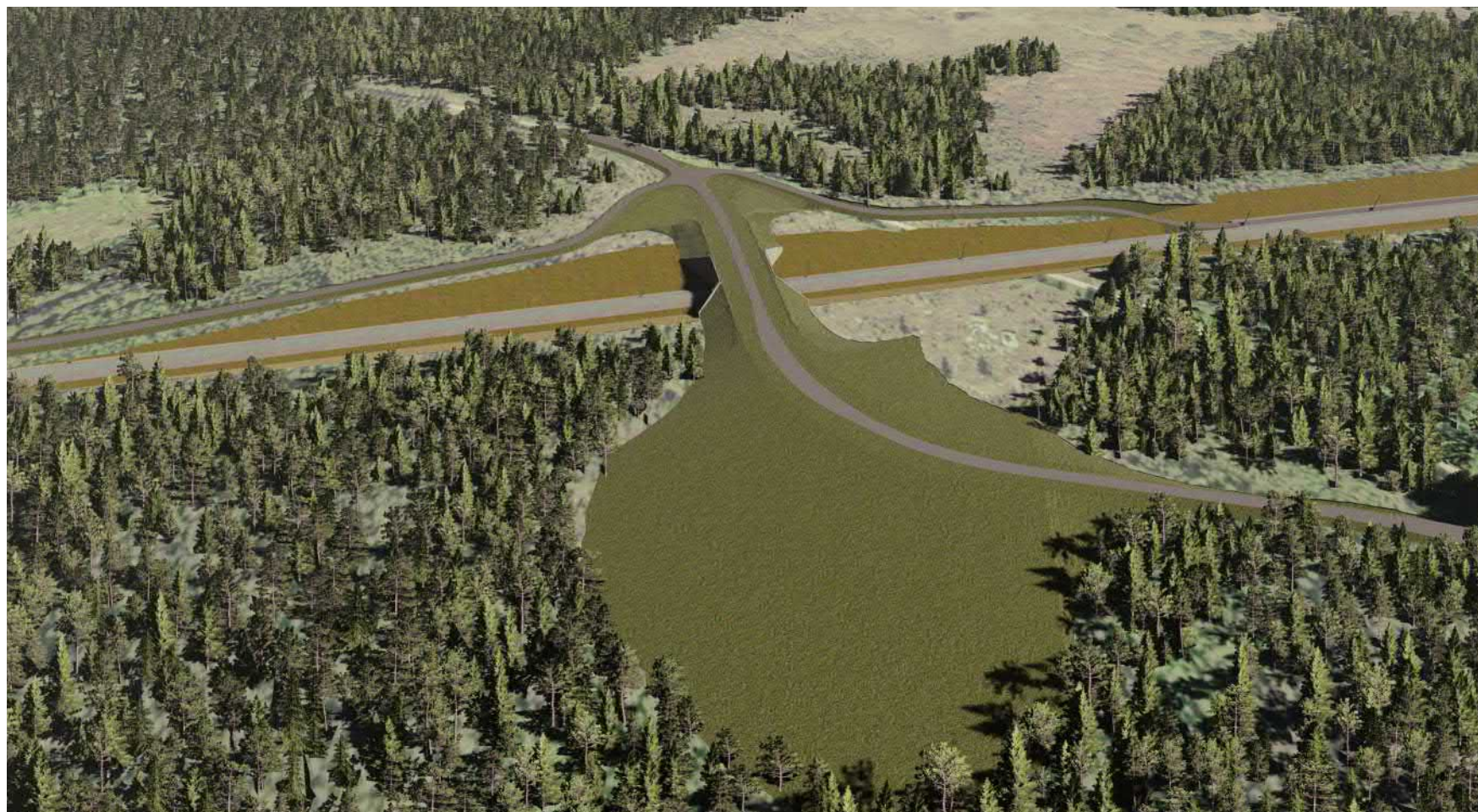
Figur 4.1-6. 3D-vy över viltpassage 39+200 och järnvägens passage genom landskapet. Den flackare slänten på 1:10 gröngörs men lämnas i övrigt orörd. Skog kommer dock tillåtas växa upp på de flacka slänterna via naturlig återväxt.
