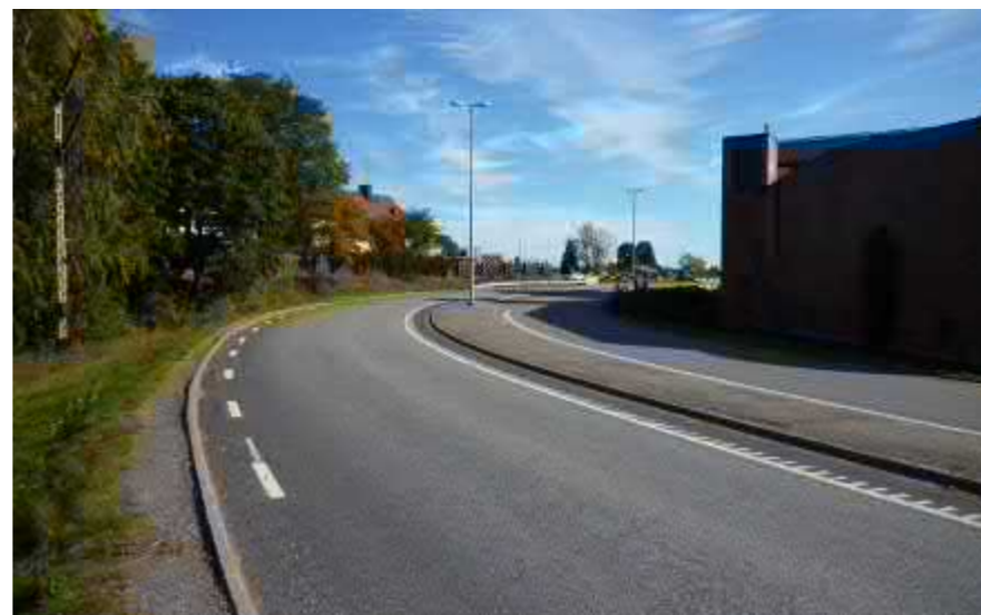
Figur 23. Det saknas gångbana/gång- och cykelbana längs väg 77 vid kurvan vid badhuset/centrumhuset (baksidan av fritidsgården Punkten).
