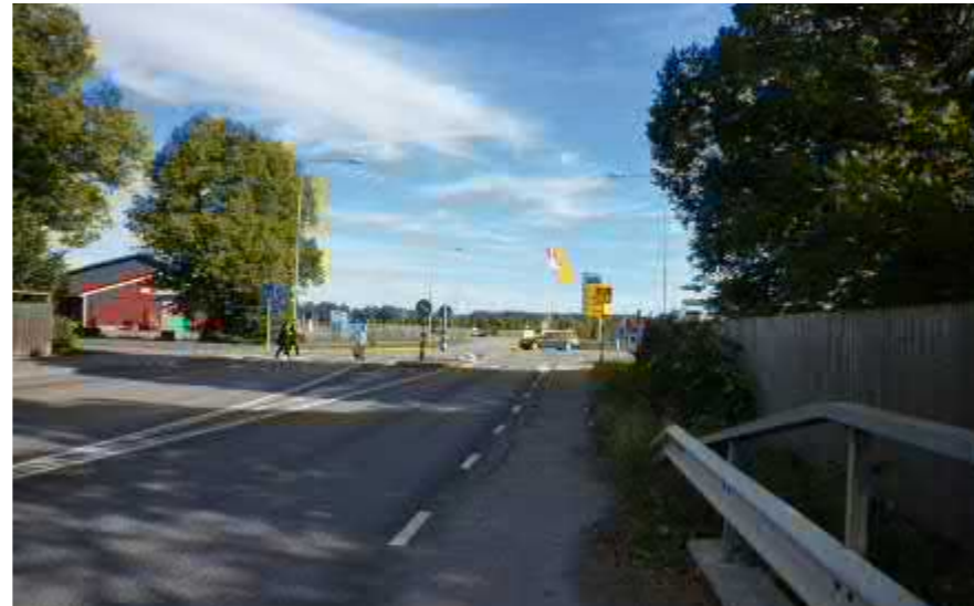
Figur 21. Många barn tycker att övergångsstället vid korsningen med väg 280 i östra Rimbo är otryggt. Där är också gångbanan på söder sida om väg 77 smal och i dåligt skick.
