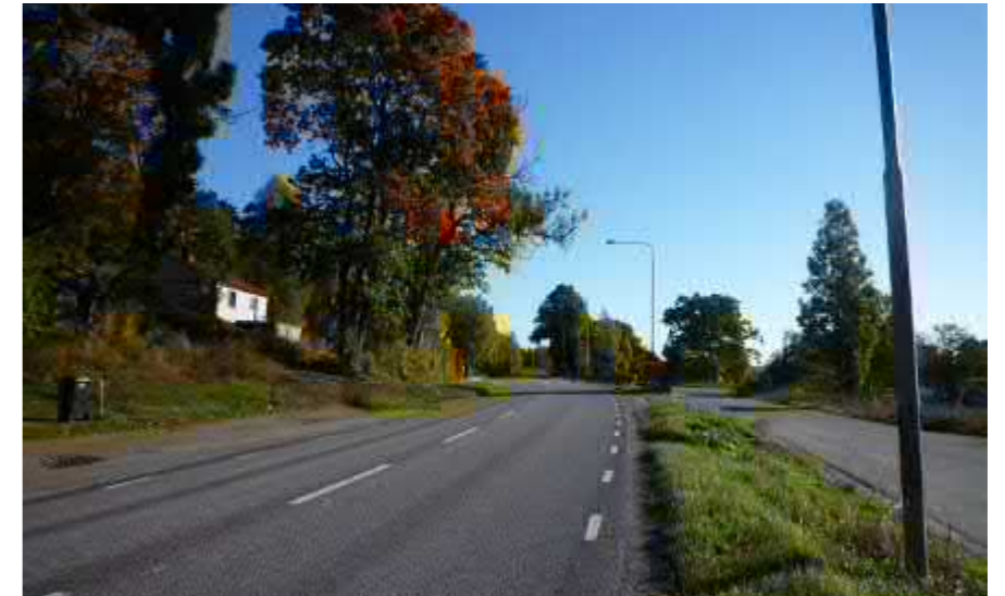
Figur 24. Många barn tycker att det är otryggt vid Finsta station (busshållplats) i centrala Finsta längs väg 77 eftersom det inte finns några gångbanor längs vägen.
