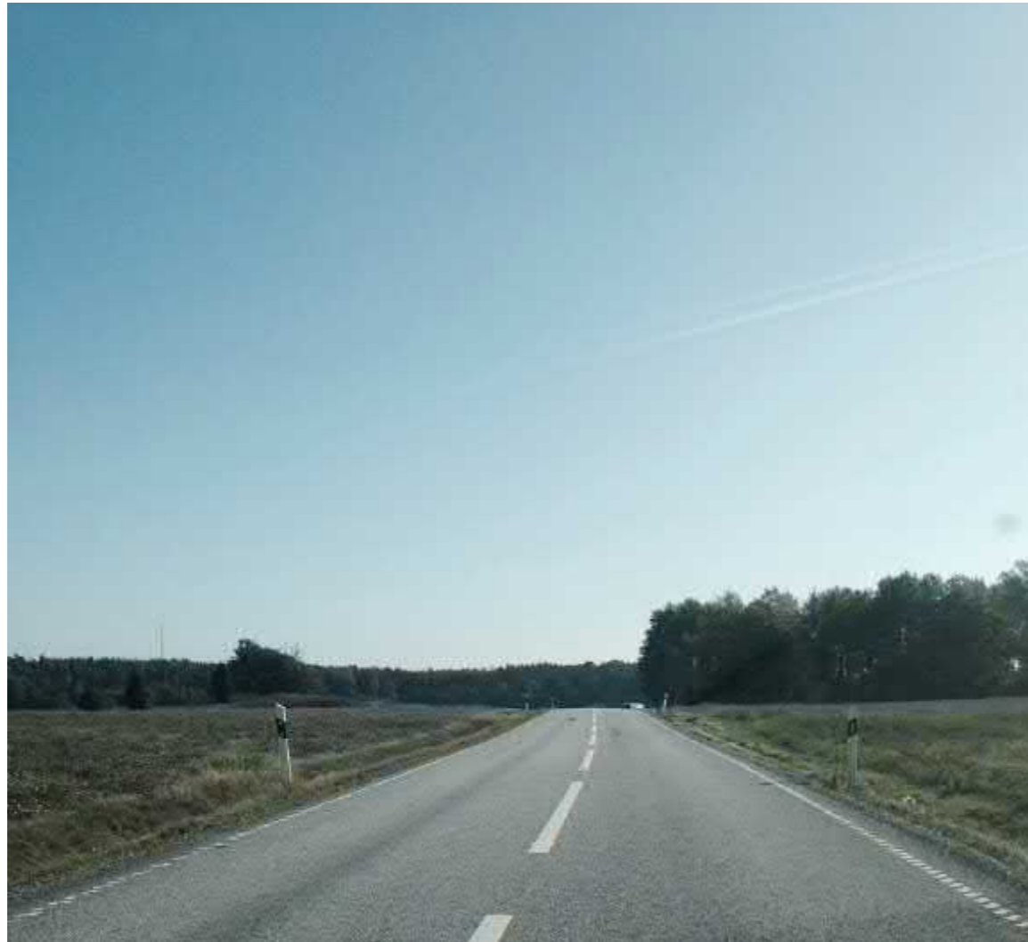
Figur 7. Siktsvacka väster om Gottröra, östlig körriktning.
