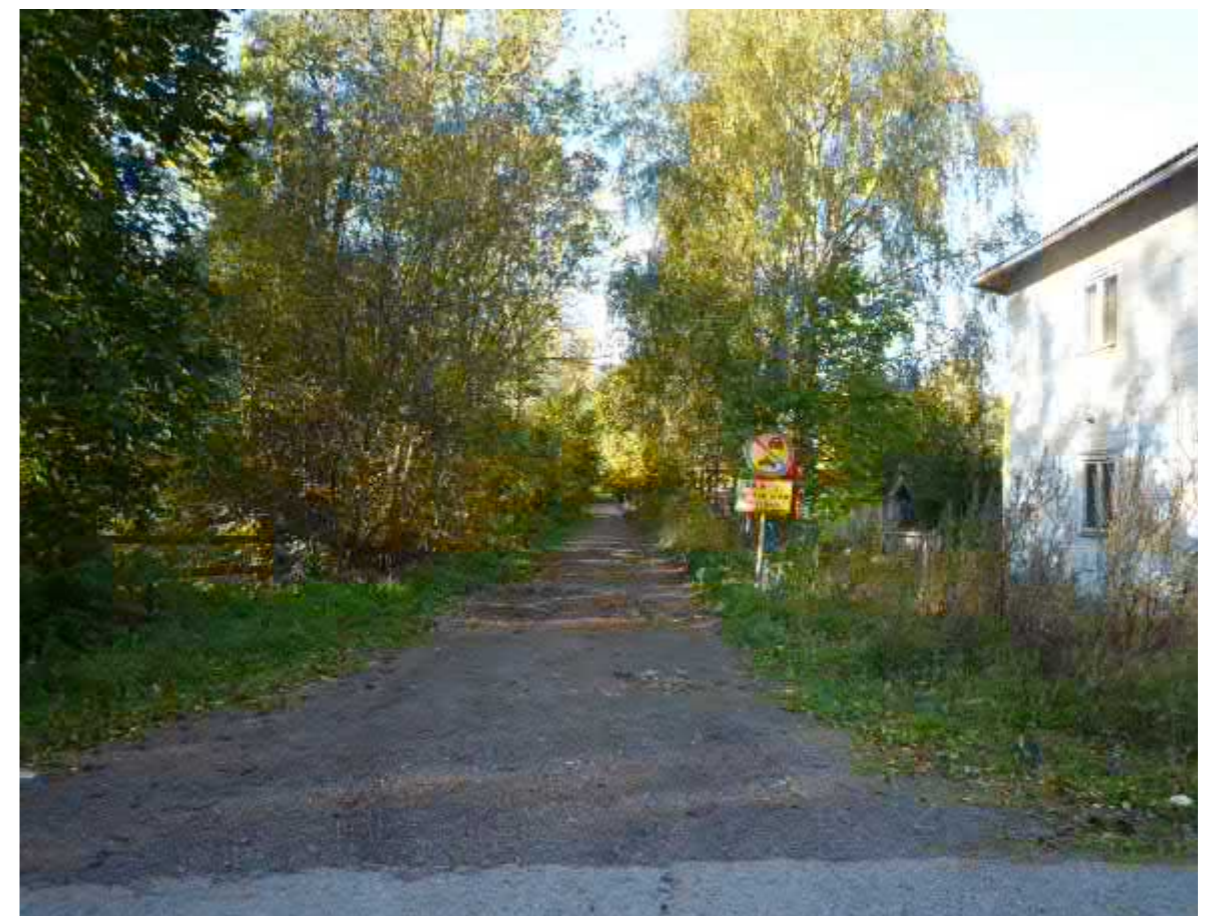
Figur 28. Den gamla banvallen mellan Rimbo och Finsta används som gång- och cykelstråk. Banvallen saknar asfaltbeläggning, belysning och underhålls inte.
