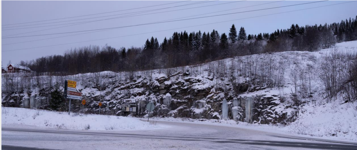
Figur 11 – Foto mot nordost över E14 vid korsningen med Fröåvägen som bland annat leder upp till området Björnen.
