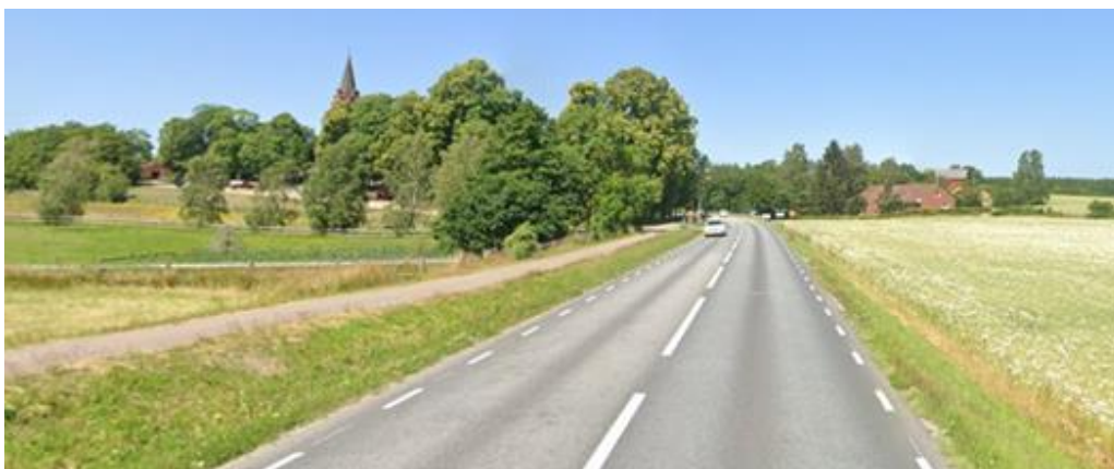
Figur 25: Exempel på gång och cykelväg vid södra delen av Billinge i landsvägsmiljö, separerad med skiljeremsa
