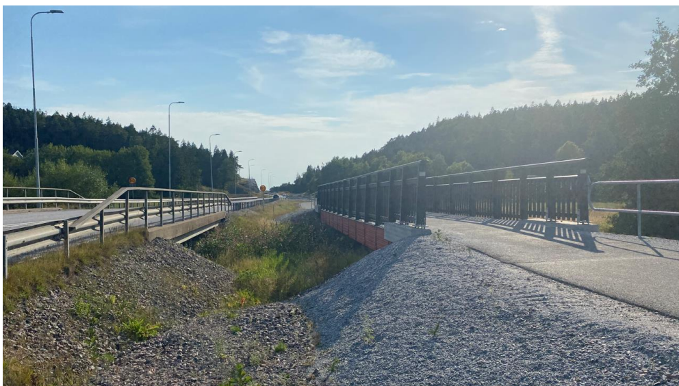
Figur 26 – Exempelbild på liknande situation med tvärsänd träbro vid Varekil, Orust kommun
