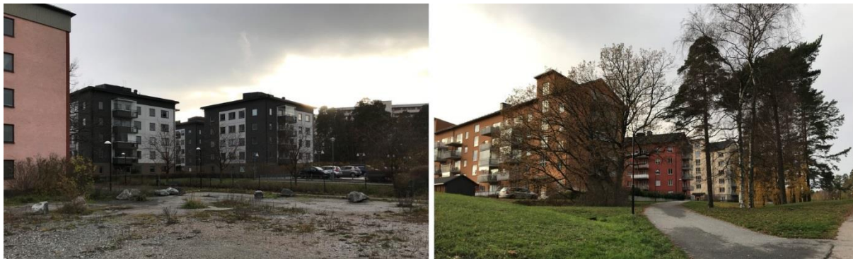
Figur 7. Flerbostadshus inom infiltrationsområdet Hässelby.
