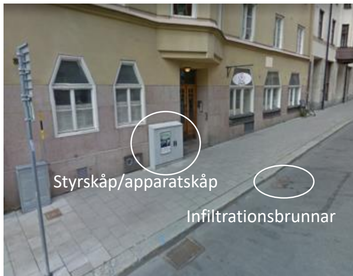
Figur 11. Exempel på infiltrationsanläggning i stadsmiljö.
