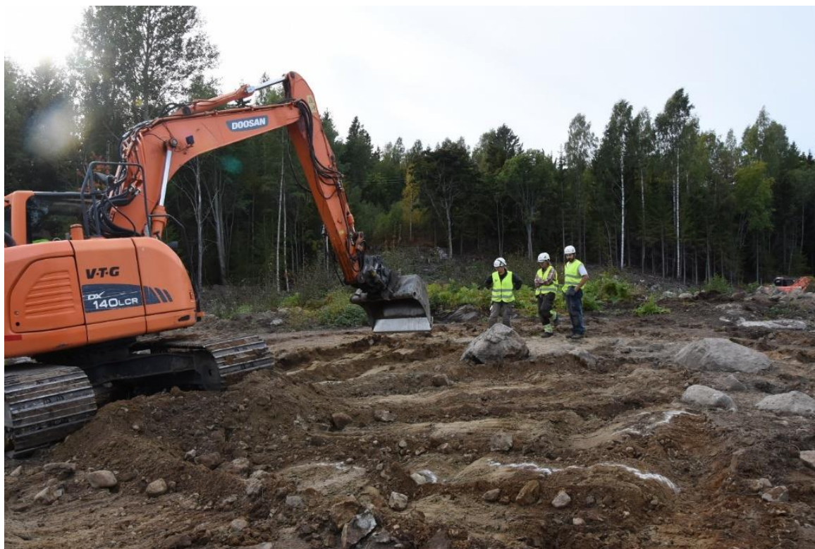
Figur 14. En sista schaktning. Foto från nordost.
