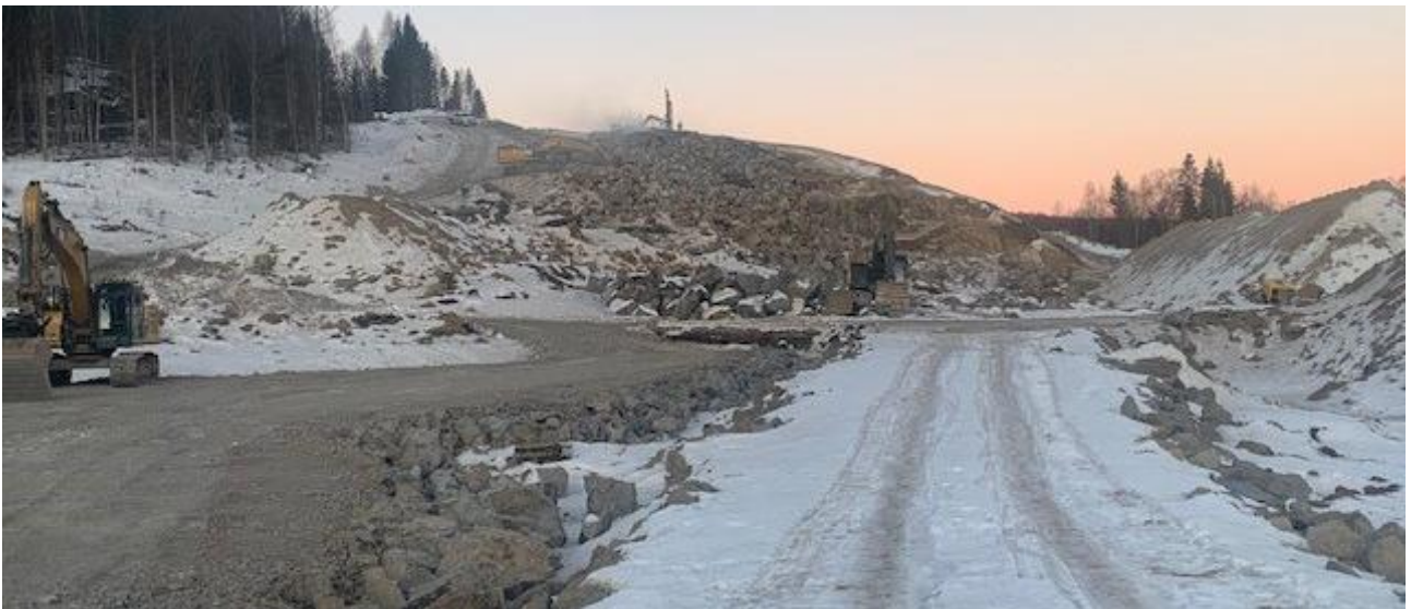
Från och med måndag 24 januari gör vi förändringar i tiderna för sprängarbeten i Maland.
