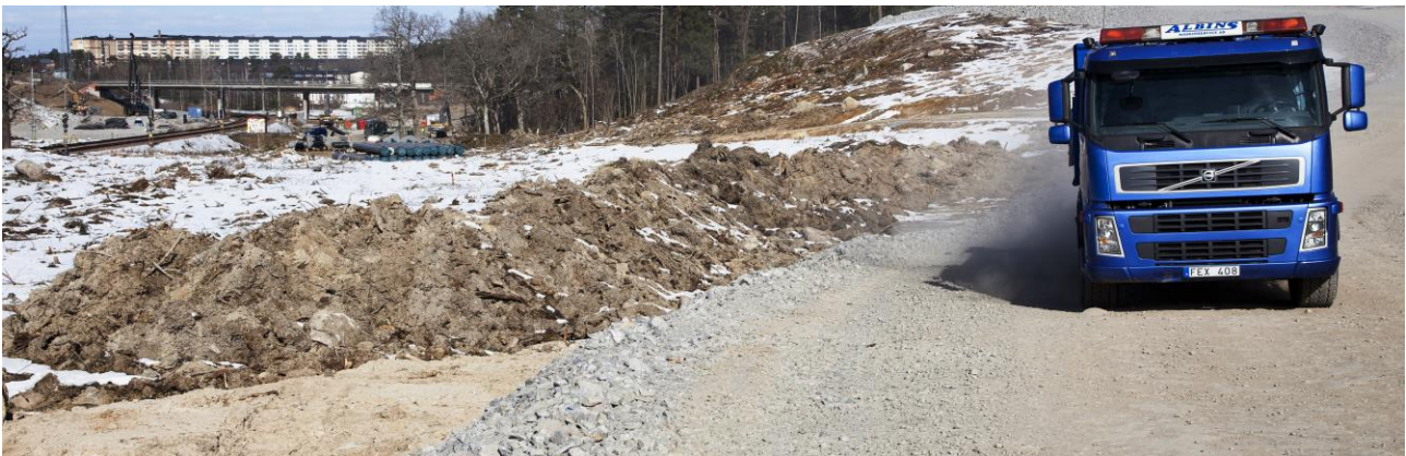
Se upp för byggtrafik i ditt område under arbetet med den nya vägen och rivningen av inlösta fastigheter.
