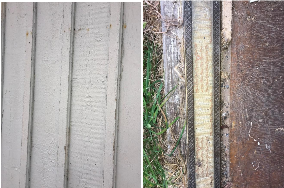
Lockpanel och äldre matta i uthuslängan. Tyder på att byggnaden är uppförd eller moderniserats under 1920–40-talet.
