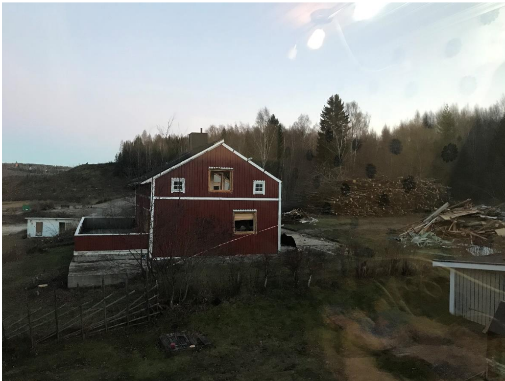
Byggnaden under rivning
