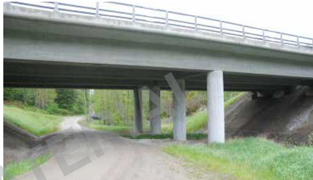
Exempel på en faunaanpassad passage i en dalgång med en bäck längs E6 i Bohuslän. Foto: Mats Lindqvist (Trafikverket).
