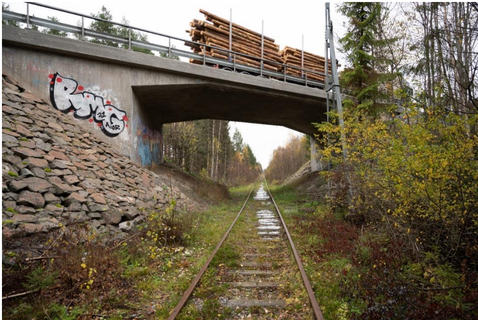
Figur 4.5 – Bro 21-205-1 är en vägbro över järnvägen Dellenbanan.
