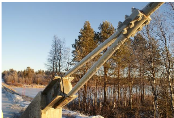
Figur 2 Backstagen och hängarna har ett flertal skador.
