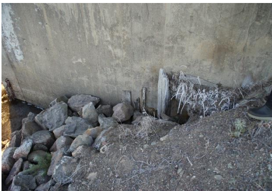
Figur 1 Konerna runt brofästena är utsatta för erosion
