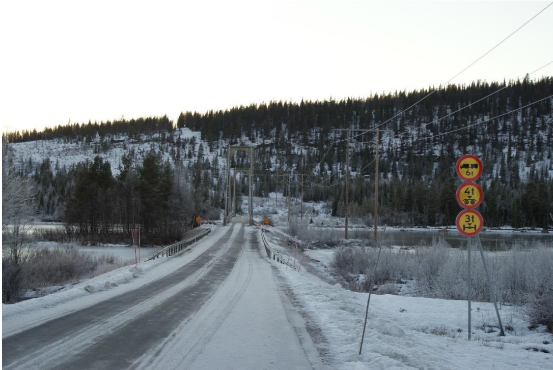
Figur 3 Den befintliga vägen byggs om och breddas och ansluter mot den nya bron. Ombyggnaden innebär att vägens profil kommer att behöva höjas. Bron sedd från norra landfästet.
