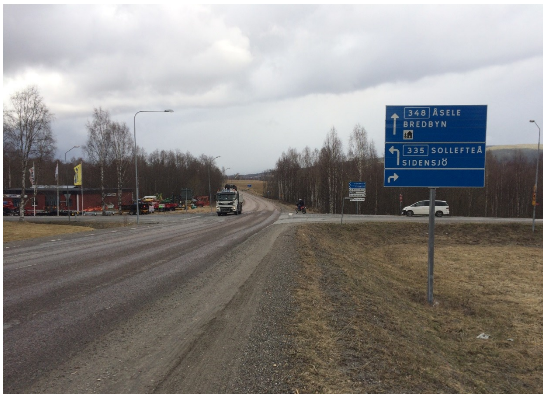
Figur 6. Korsning väg 335/väg 348/väg 938 såsom den ser ut idag med vy mot norr. (Foto: Jenny Lundberg, Sweco).
