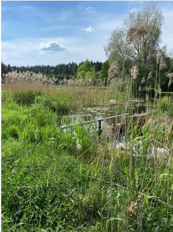
Figur 44. Dämme som bestämmer nivån för dammen vid Nedre kvarn mellan delsträcka 4 och 5. Dämmet utgör ett vandringshinder för fisk. Delsträcka 5 bedöms utgöras hydromorfologiska typen Zz eftersom saknar vattendragskaraktär och därmed avviker från vattendragets referensförhållande.
