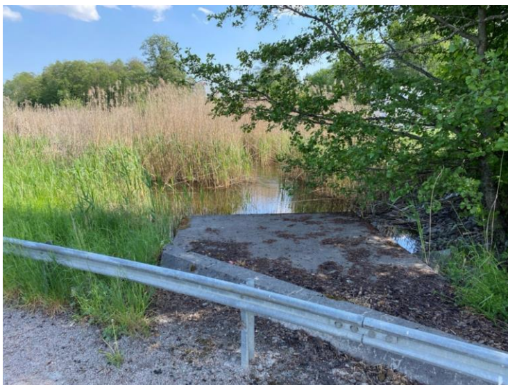
Figur 44. Dämme som bestämmer nivån för dammen vid Nedre kvarn mellan delsträcka 4 och 5. Dämmet utgör ett vandringshinder för fisk. Delsträcka 5 bedöms utgöras hydromorfologiska typen Zz eftersom saknar vattendragskaraktär och därmed avviker från vattendragets referensförhållande.
