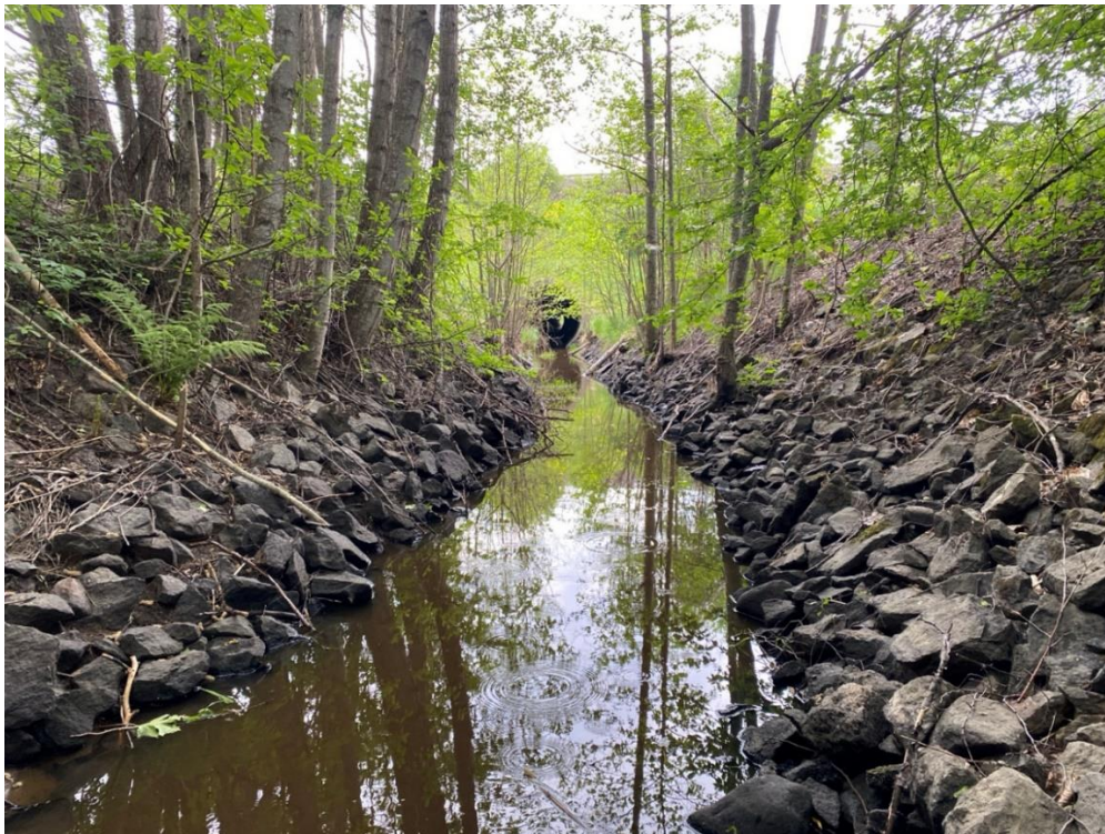
Figur 52. Inom den östra delen av delsträcka 1 i direkt anslutning till befintlig järnväg är vattendraget rätat och bottensubstratet utgörs av erosionsskydd.
