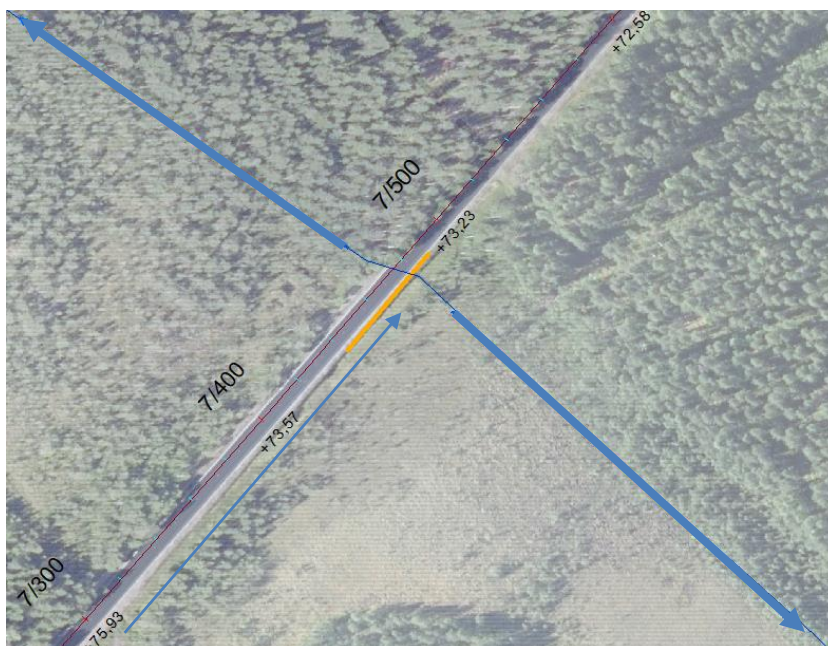
Figur 3. Översikt av problemområde enligt skadeinventering (orange) längs med högra diket genom Mjömyran samt schematiskt utritade rinnvägar.
