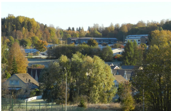
Figur 4.8. Flerfamiljshusen i Ljustadalen/Johannedal ligger traditionsenligt uppe i slänten, medan villabebyggelsen till stor del byggts på det som tidigare var åkermark.
