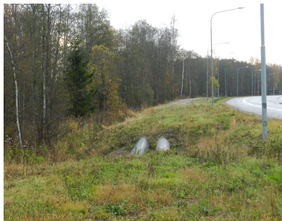
Figur 4.18 Fjärrvärmeledningar går parallellt med väg 622 på sträckan väster om Söndagsvägen.
