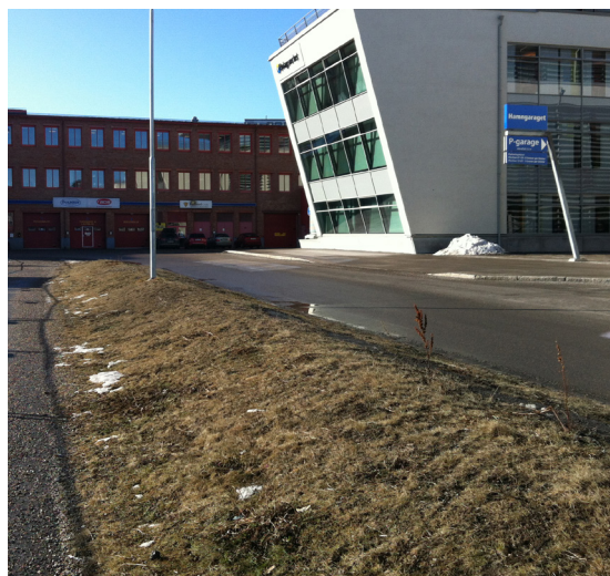
Figur 5.7 Exempel på låg jordvall mellan väg och gång- och cykelväg. Den låga vallen ger en mer skyddad känsla i ett läge där det inte är möjligt att göra diken.
