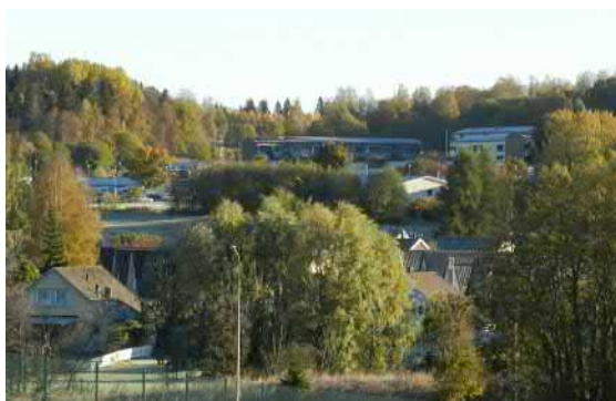
Figur 4.8. Flerfamiljshusen i Ljustadalen/Johannedal ligger traditionsenligt uppe i slänten, medan villabebyggelsen till stor del byggts på det som tidigare var åkermark.
