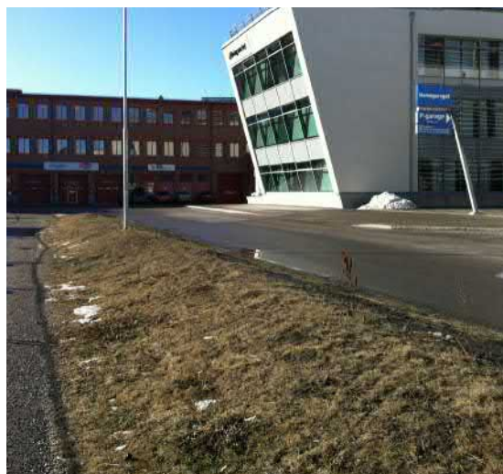
Figur 5.5 Exempel på låg jordvall mellan väg och gång- och cykelväg. Den låga vallen ger en mer skyddad känsla i ett läge där det inte är möjligt att göra diken.
