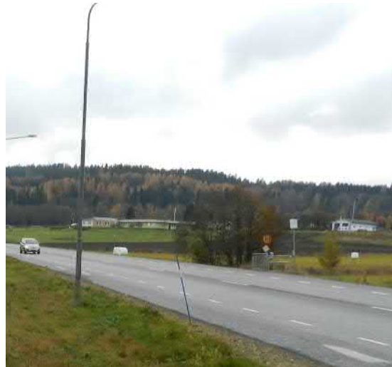
Figur 4.2 Det finns ingen passage eller gångbana för gående som vill till busshållplatsen vid Torsdagsvägen.
