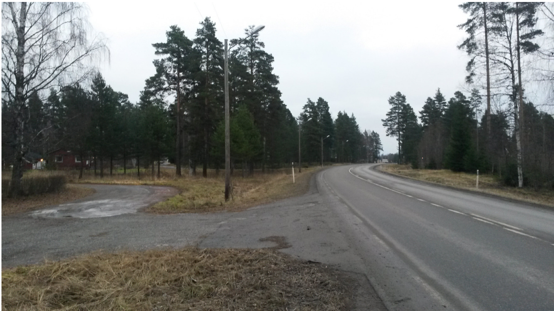
Figur 5.2 Anslutning i sektion 0/815 som föreslås stängas. Till vänster i bild syns även den enskilda vägen som föreslås byggas om till gång- och cykelväg och därmed stängas för motorfordonstrafik.
