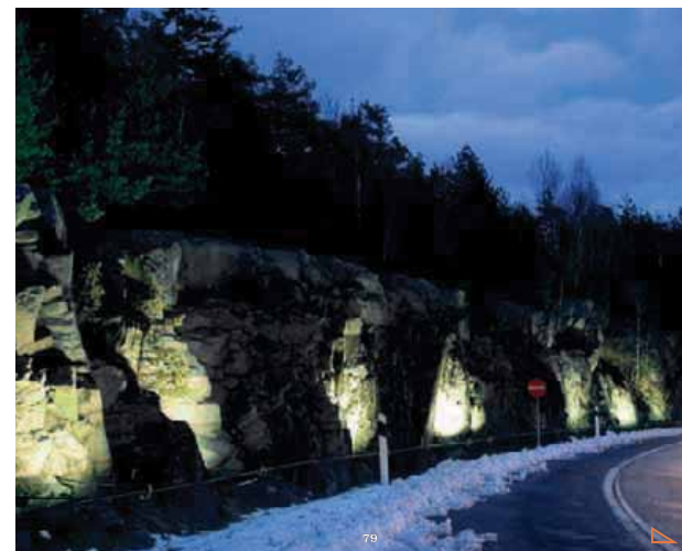
Figur 19. Belysning vid Flygplatsmotet, väg 40. Bild hämtad från: Designprogram Göteborgsregionens infarter, Vägverket
