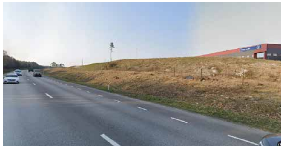
Figur 33. Utförd terrängmodellering vid Logistikcentrum i anslutning till blivande Kålsederdsmotet på västra sidan av vägen.
