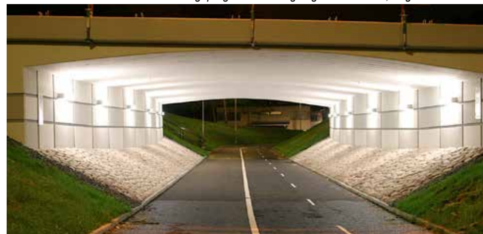
Figur 20. Exempel på belysning och bearbetning av vägg i gång- och cykelport.
