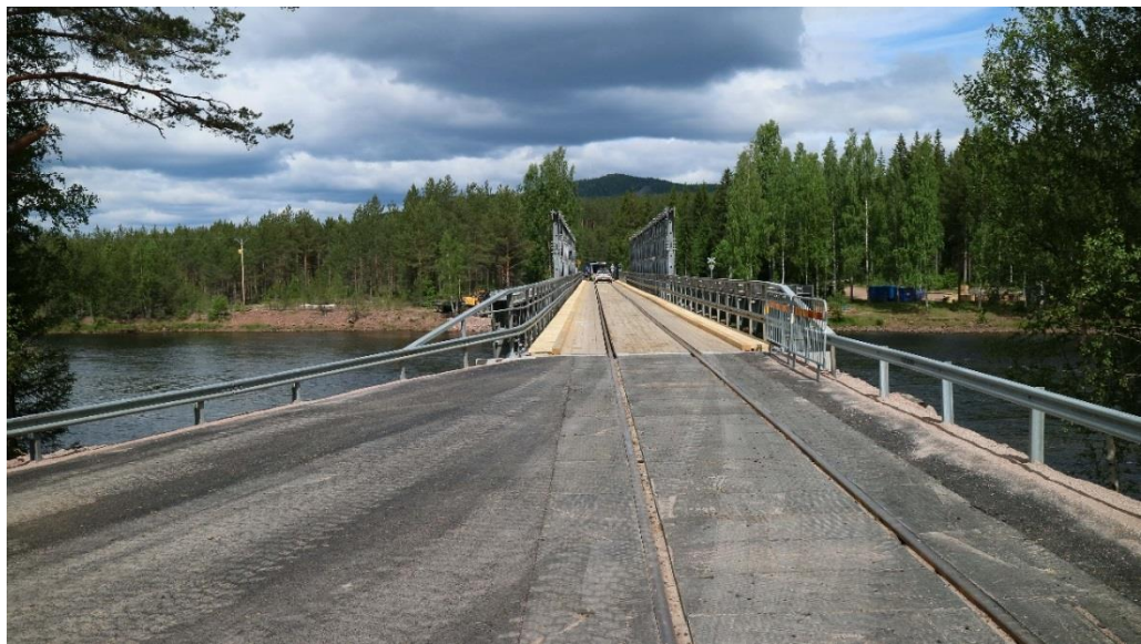
Figur 3. Foto på ersättningsbron. Källa Trafikverket.
