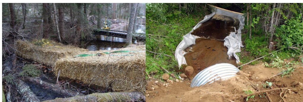
Figur 10. Exempel på åtgärder mot grumling av vattendrag. Halmbalar till vänster och geotextil till höger (Källa: t.v. foto Trafikverket (Agne Gunnarsson), t.h. TR Avvattning TDOK 2014:0046).
