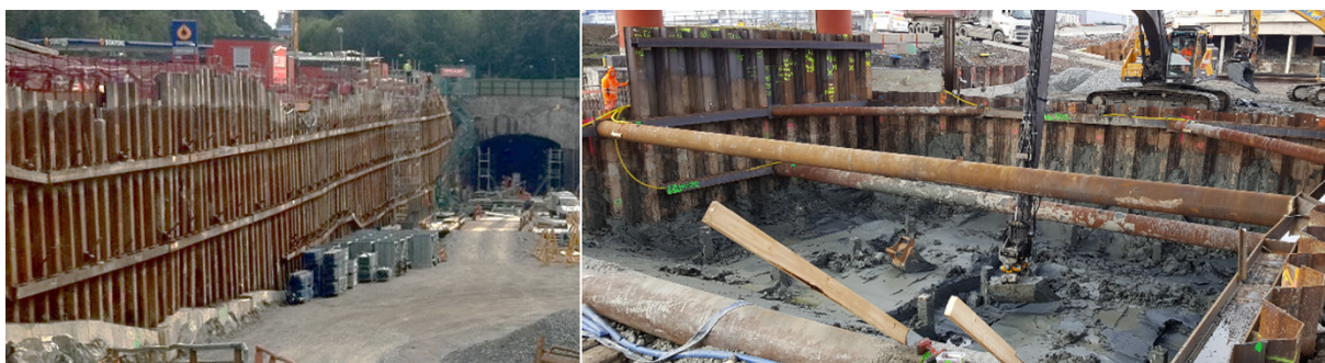
Figur 9. Illustration av stora sponter. På delområde Stavsjö-Böksjö kommer eventuella sponter att vara av mindre omfattning.
