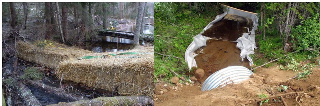
Figur 11. Exempel på åtgärder mot grumling av vattendrag. Halmbalar till vänster och geotextil till höger (Källa: t.v. foto Trafikverket (Agne Gunnarsson), t.h. TR Avvattning TDOK 2014:0046).
