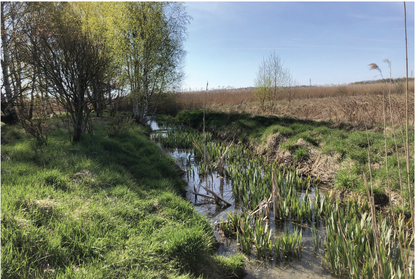
Foto på dike som leder mot Bråviken. Fotat mot sydost
