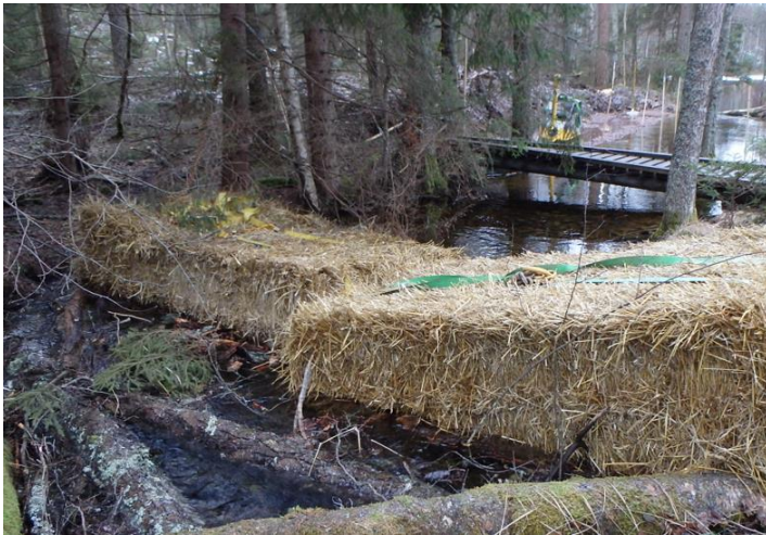
Figur 15. Ett exempel på åtgärd mot grumling i vattendrag är att lägga ut halmbalar (Källa: foto Trafikverket (Agne Gunnarsson.)
