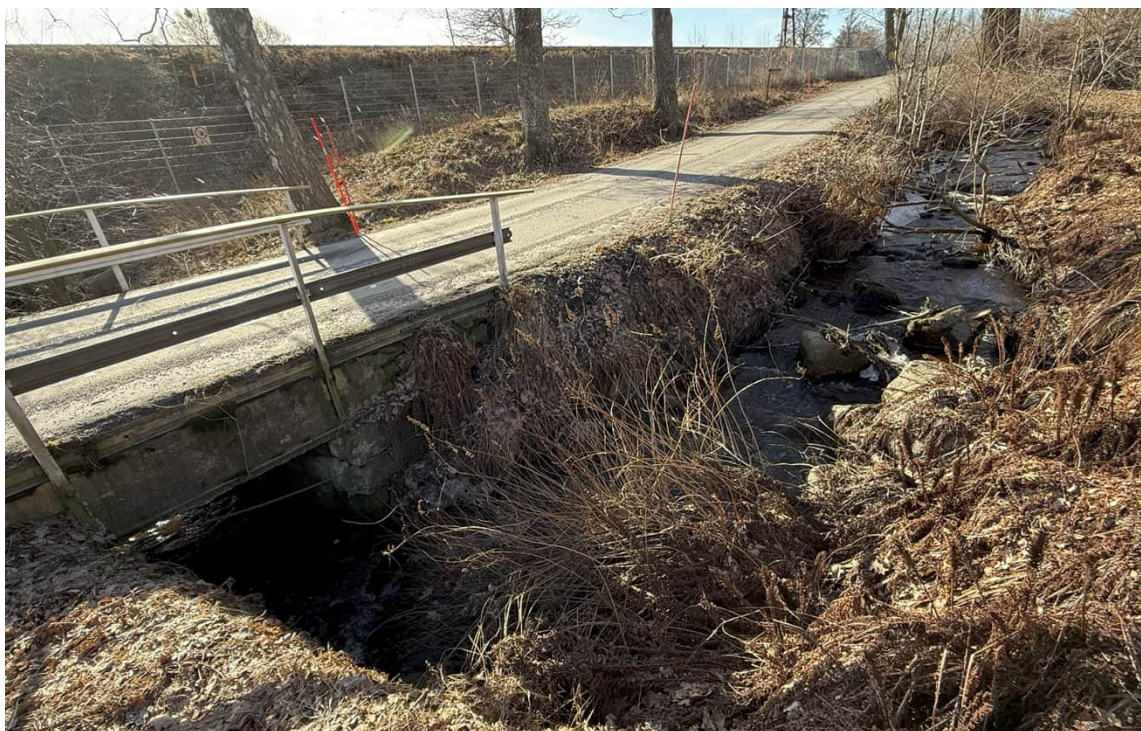
Figur 20. Omgrävd sträcka av Getåbäcken nära uppströms Södra stambanan. Vid kröken i fotots förgrund fanns tidigare ett enkelt dämme som fungerade som vandringshinder för lekvandrande öring och flodnejonöga, men hindret revs ut i slutet av 1990-talet. Utrivningen har lett till erosion uppströms och sträckan upp till nästa krök utgör numera en knickzon som över tid kommer att vandra uppströms i vattendraget. Fotografiet är taget 80 meter uppströms bäckens utlopp i Bråviken, inom den centrala delen av sträcka 3. Foto Jonas Edlund 2025-03-03.
