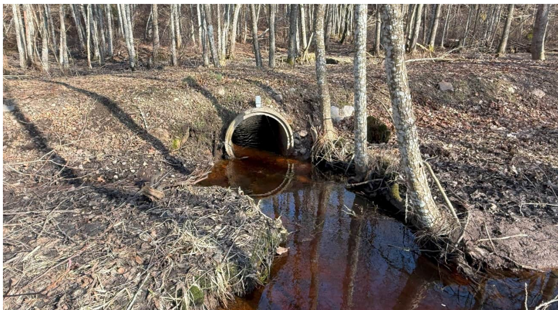
Figur 19. Nyttillkommen bestämmande sektion med betongtrumma Ø 0,8 meter och anlagd bank som tvärs över svämplanet. Den bestämmande sektionen finns inom nedre delen av sträcka 17, cirka 130 meter uppströms vägpassagen vid Algutsbo och har nummer 14 i karteringen. En liknande nyttillkommen bestämmande sektion finns cirka 90 meter nedströms vägpassagen vid Algutsbo och har nummer 13 i karteringen. Foto Jonas Edlund 2025-03-07.
