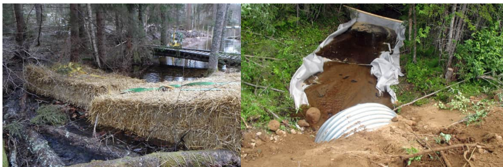
Figur 15. Exempel på åtgärder mot grumling av vattendrag. Halmbalar till vänster och geotextil till höger (Källa: t.v. foto Trafikverket (Agne Gunnarsson), t.h. TR Avvattnings TDOK 2014:0046).
