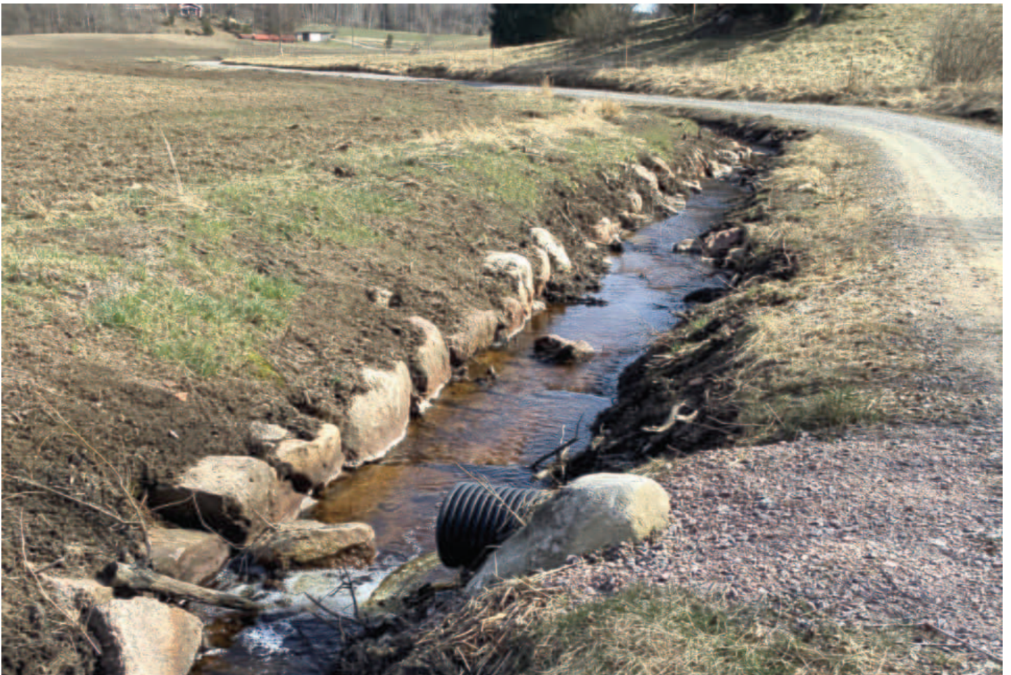
Foto på Rödmossebackens sträckning intill grusväg, fotat mot sydost
