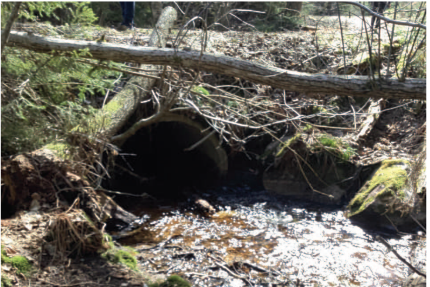
Aksjöbäckens passage i trumma under befintlig väg, fotat mot söder
