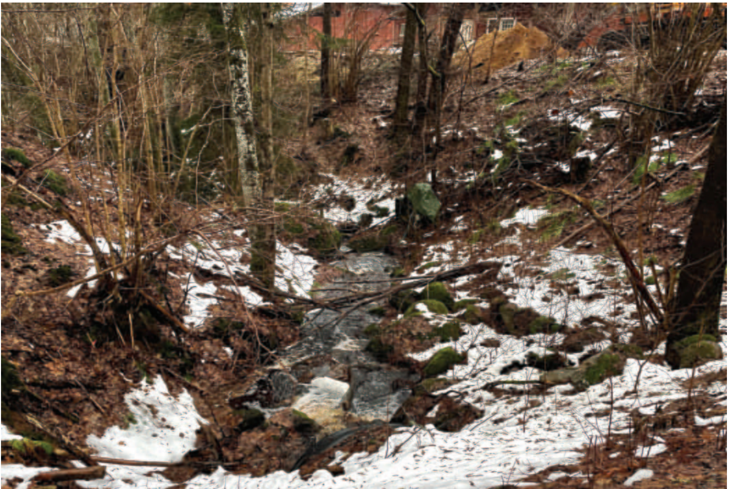
Foto på Getåbäcken vid Lugnet, vägtrumman syns längst ner i bilden. Fotat mot söder från väg
