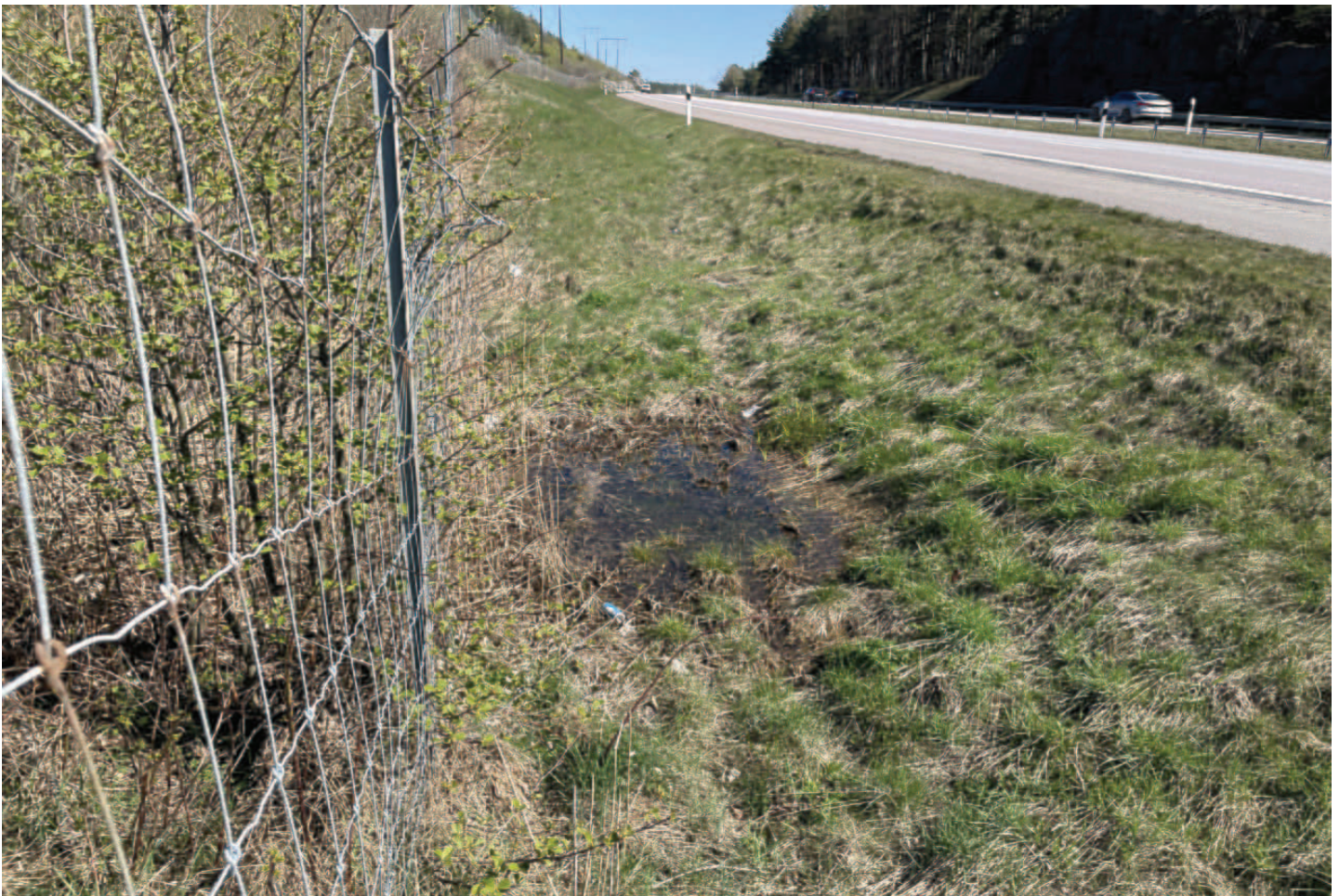
Läge för kulvertering under E4. Fotat mot öster
