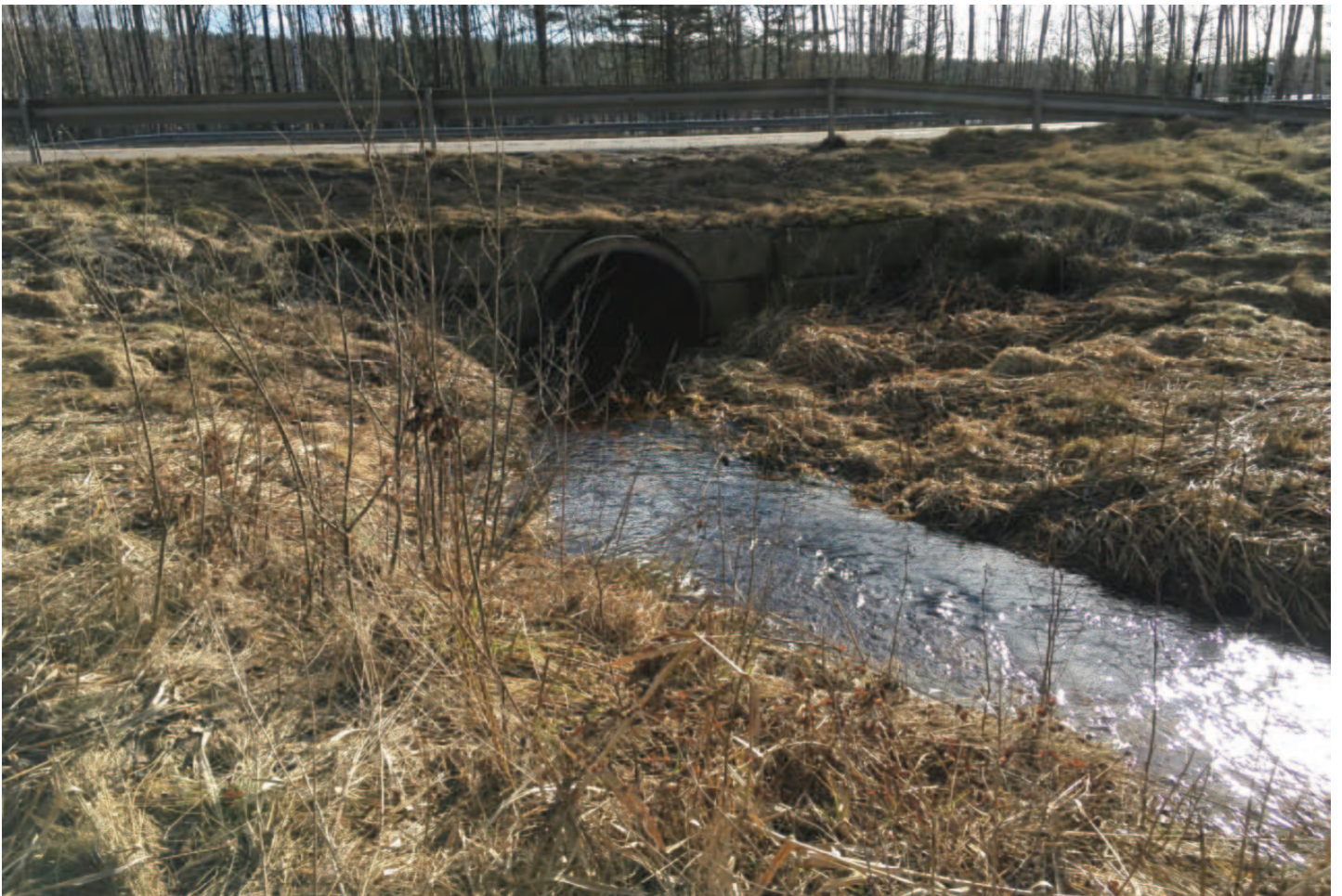
Foto på Åksjöbäckens passage i trumma under E4, fotat mot öster
