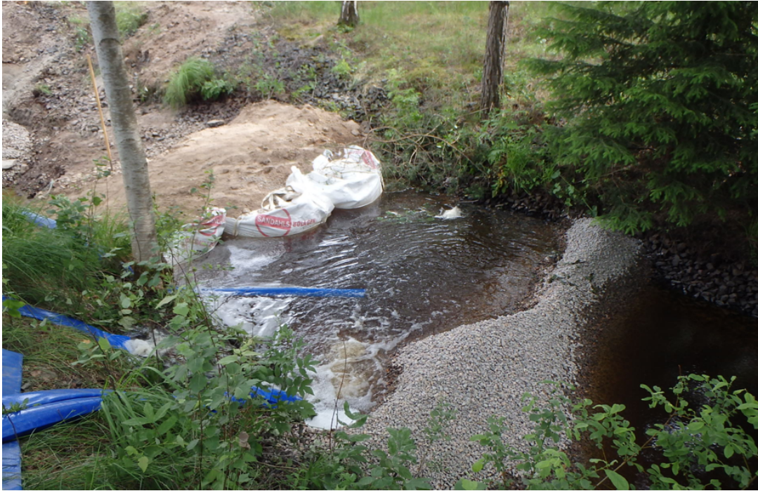
Figur 10. Exempel på tillfälligt dämme i vattendrag. Vatten pumpas förbi arbetsområdet.
