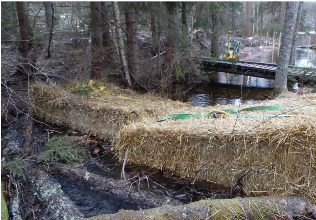
Figur 11. Exempel där halmbalar lagts ut för att dämme vattenflödet och samla upp sediment vid arbetet i vattenområden (Källa, foto Trafikverket (Agne Gunnarsson))
