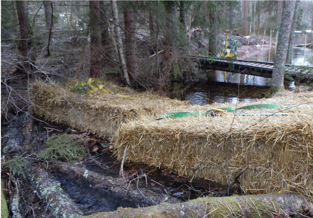
Figur 11. Exempel där halmbalar lagts ut för att dämna vattenflödet och samla upp sediment vid arbetet i vattenområden (Källa, foto Trafikverket (Agne Gunnarsson))
