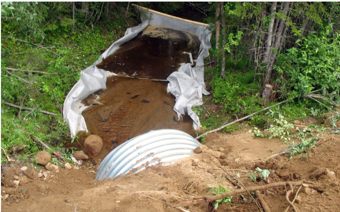
Figur 12. Exempel där geotextil lagts ut för att samla upp sediment vid anläggande av trumma. Källa (Trafikverket 2014)
