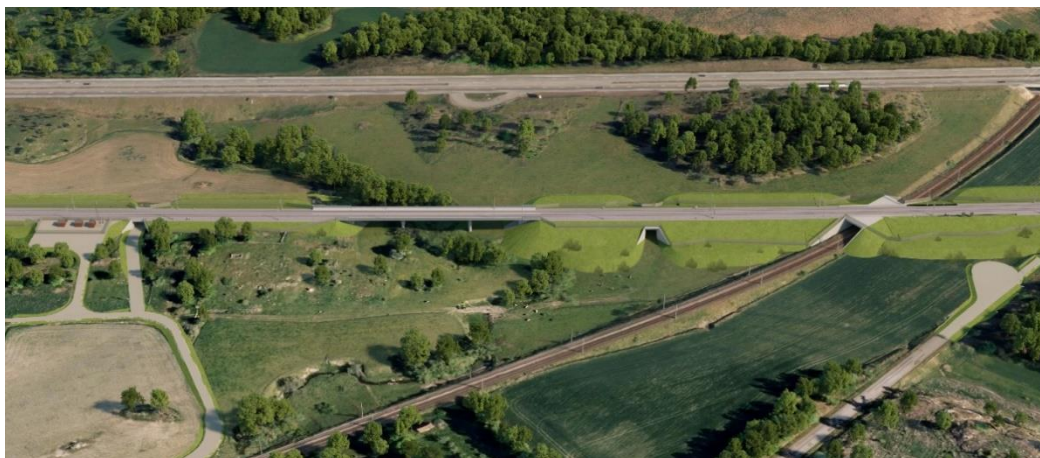
Figur 11. Visualisering av den föreslagna passagen för järnvägen förbi Södra stambanan och en längre bro över Eggebybäcken.
