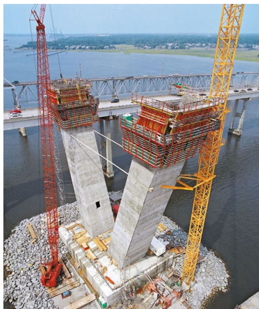
Figur 14. Klätterform för bropelare.
