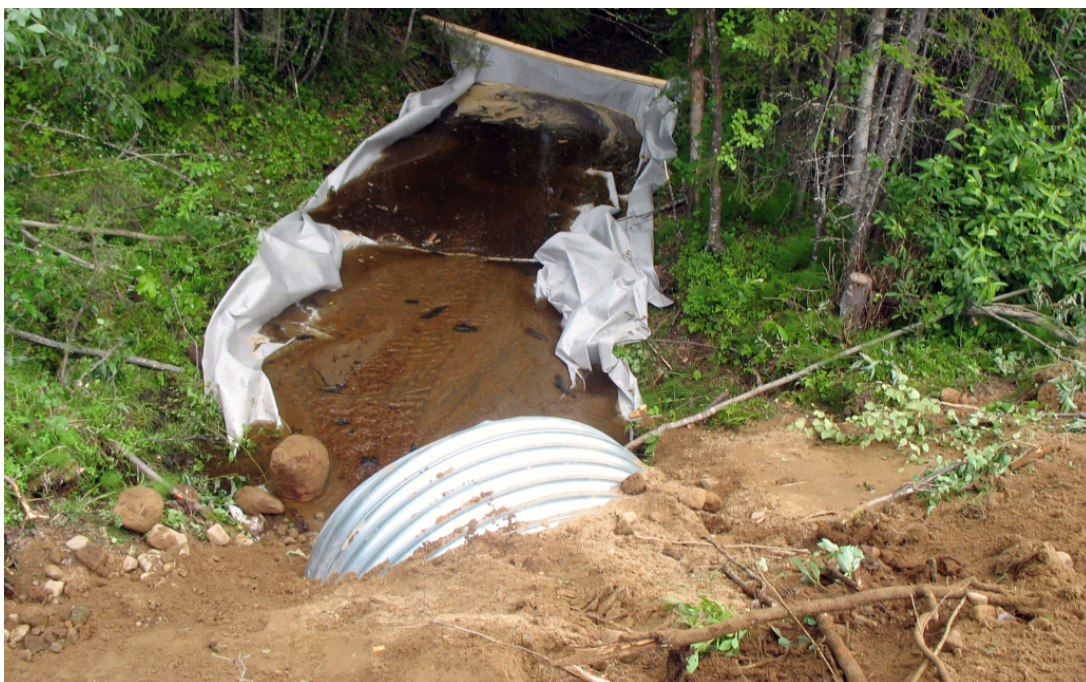
Figur 10. Exempel där geotextil lagts ut för att samla upp sediment vid anläggande av trumma. Källa (Trafikverket 2014)
