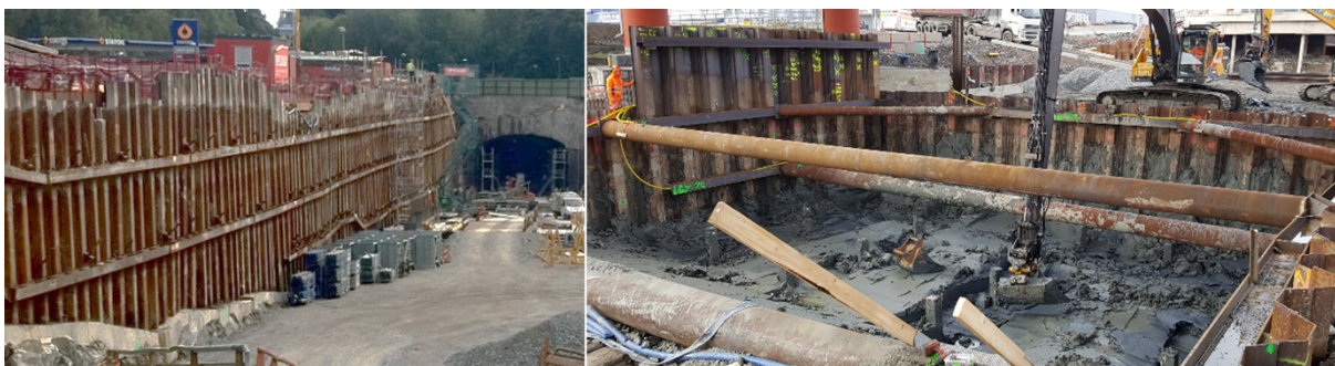
Figur 7. T.v. bakåtförankrad tätspont. T.h. stämpad tätspont.
