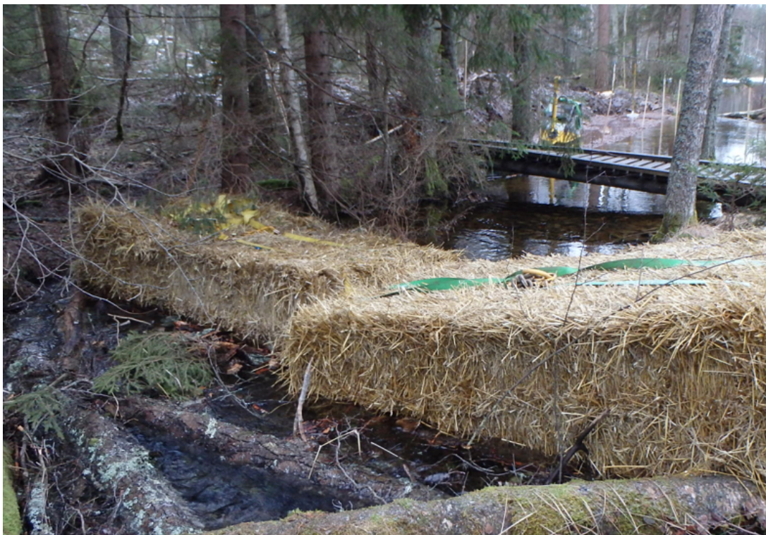
Figur 9. Exempel där halmbalar lagts ut för att dämna vattenflödet och samla upp sediment vid arbetet i vattenområden (Källa, foto Trafikverket (Agne Gunnarsson))
