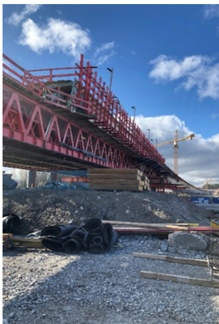
Figur 13. Formvagn som "klättrar" på pelarna.
