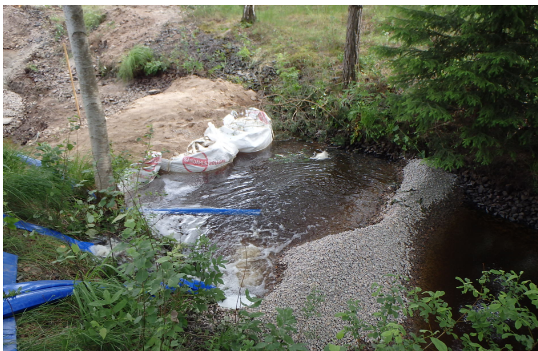
Figur 8. Exempel på tillfälligt dämme i vattendrag. Vatten pumpas förbi arbetsområdet.
