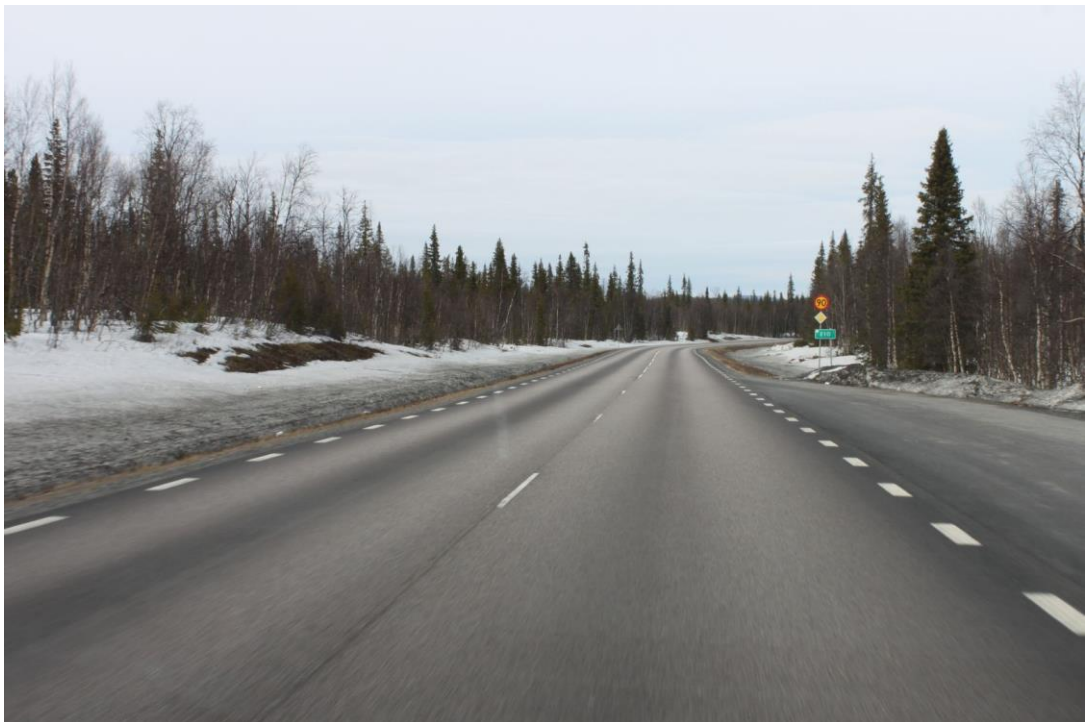
Figur 3. Väg E10 Avvakko – Lappeasuando (foto: Trafikverket)
