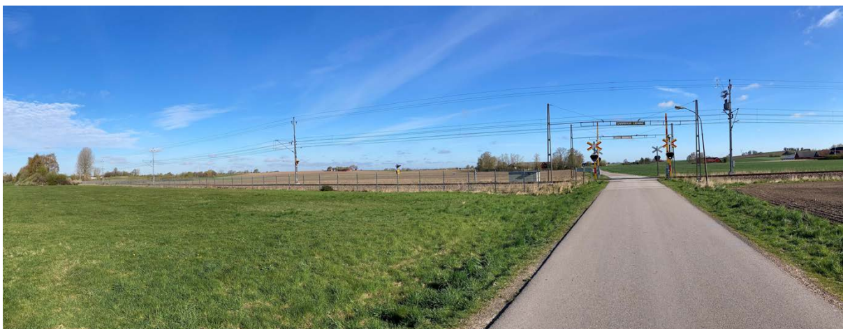
Figur 18. Bildexempel från annan järnvägssträcka som elektrifierats. Panoramavy mot bandel vid plankorsning med teknikhus, elskyddsportal och stålnätspaneler (endast aktuellt omkring stationslägen). Svag ås i fonden. Teknikhus med en storlek på cirka 6 m 2
