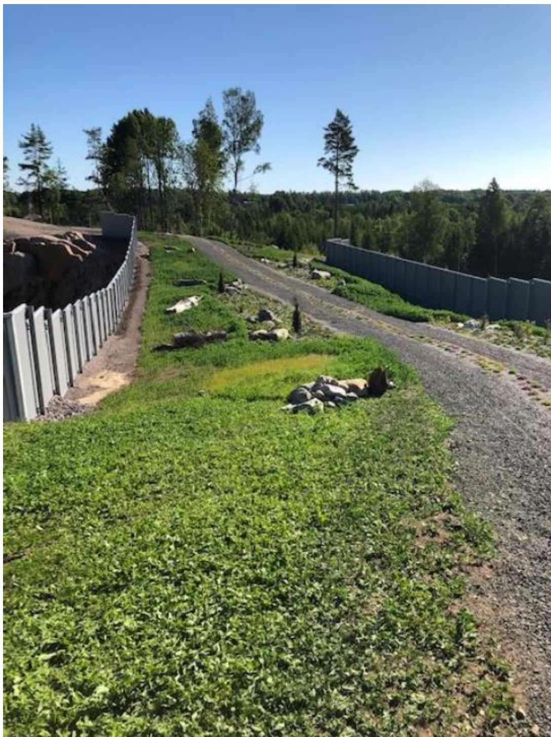
Figur 41. Exempel på faunabro, denna över väg 51 vid Pålsboda med skyddande faunaskärmar. Foto: Loxia Group.
