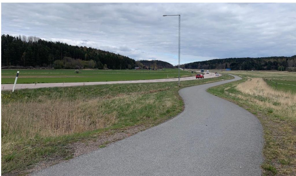
Figur 8. Separat gång- och cykelbana längs med väg 218. Foto: Loxia Group.
