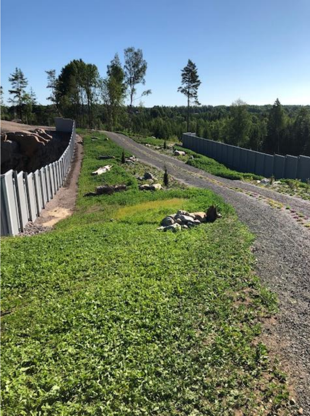
Figur 4. Exempel på faunabro, denna över väg 51 vid Pålsboda med skyddande faunaskärmar (foto Per Lord, Loxia Group).
