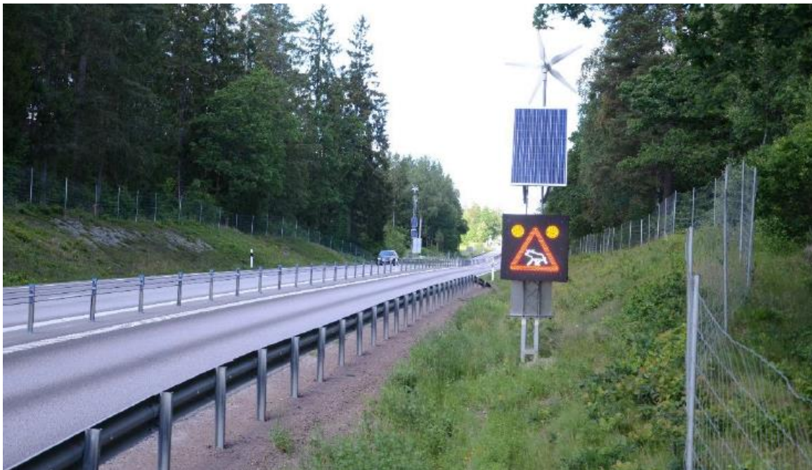
Figur 6. VMS-skyltar med ex älg-symbol skall tändas upp när vilt är i faunapassagen och därmed varna bilister. Foto från Haraldsmåla E22, faunapassagen ligger ca 250 m bortanför VMS-skylten. Foto: Mattias Olsson. Källa: Pilotprojekt vilt 3 .
