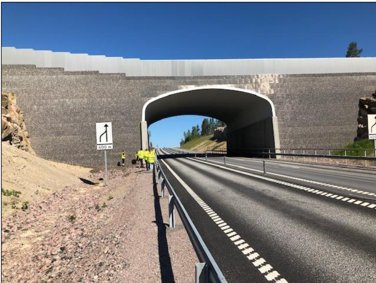
Figur 15. Faunabro uppbyggd med gabioner, denna finns i Pålsboda på väg 51, foto: Per Lord, Loxia Group.
