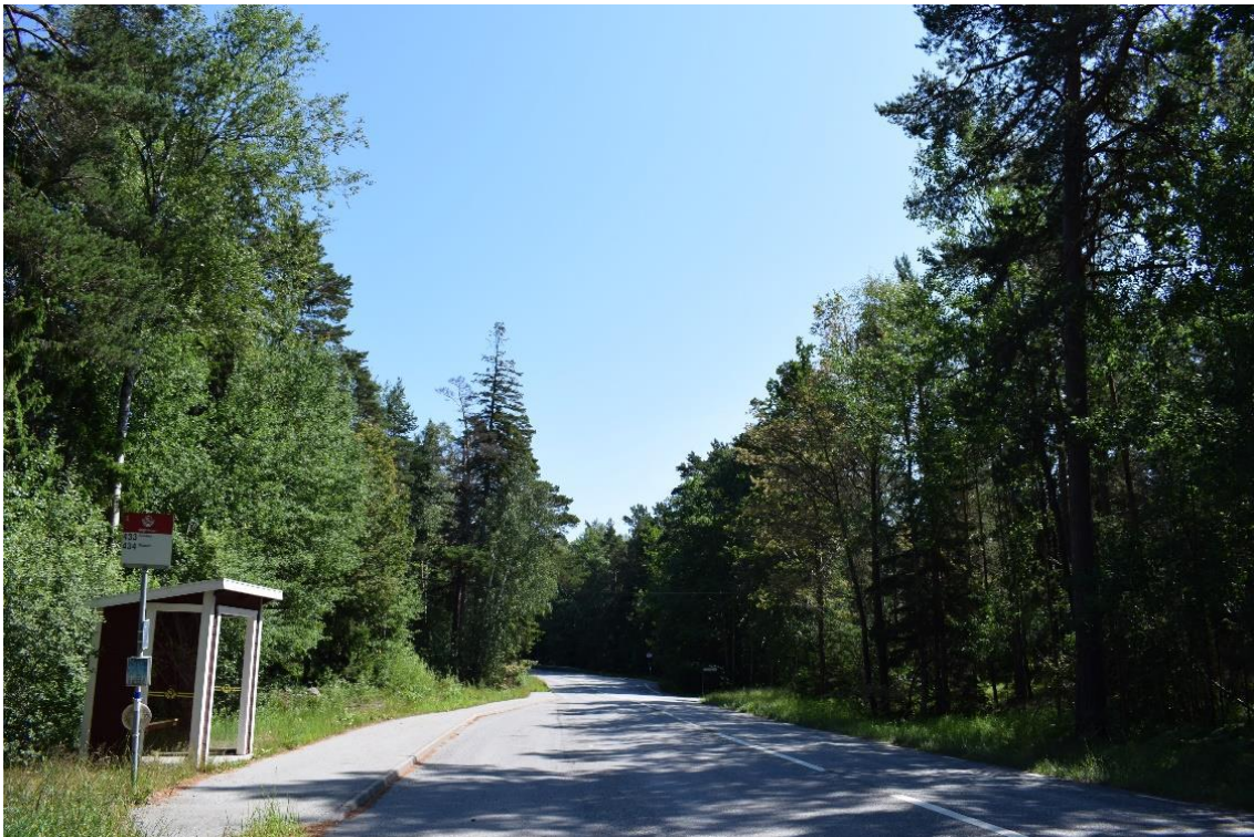
Figur 3. Busshållplatsläget Ängsvägen (42278) mot Slussen. Fotot är taget med utblick mot öster (Sollenkroka). Foto: Loxia Group.
