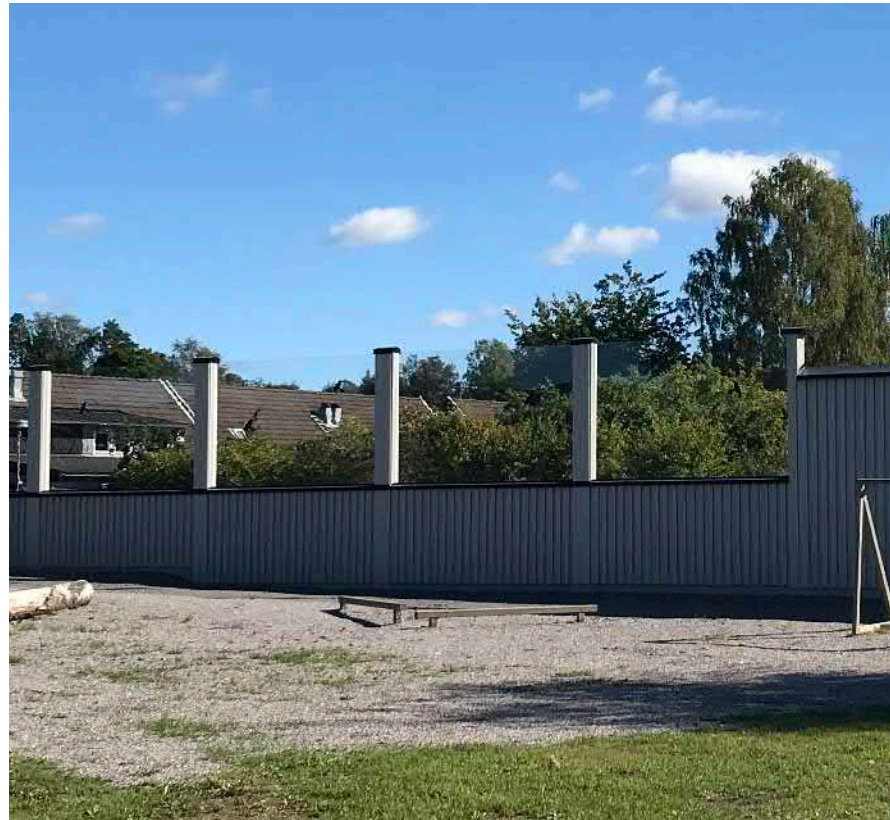
Figur 4-15 Exempel på transparent skärm med absorberande nederkant, Roslagsbanan, Stockholm. Foto: Landskapslaget
