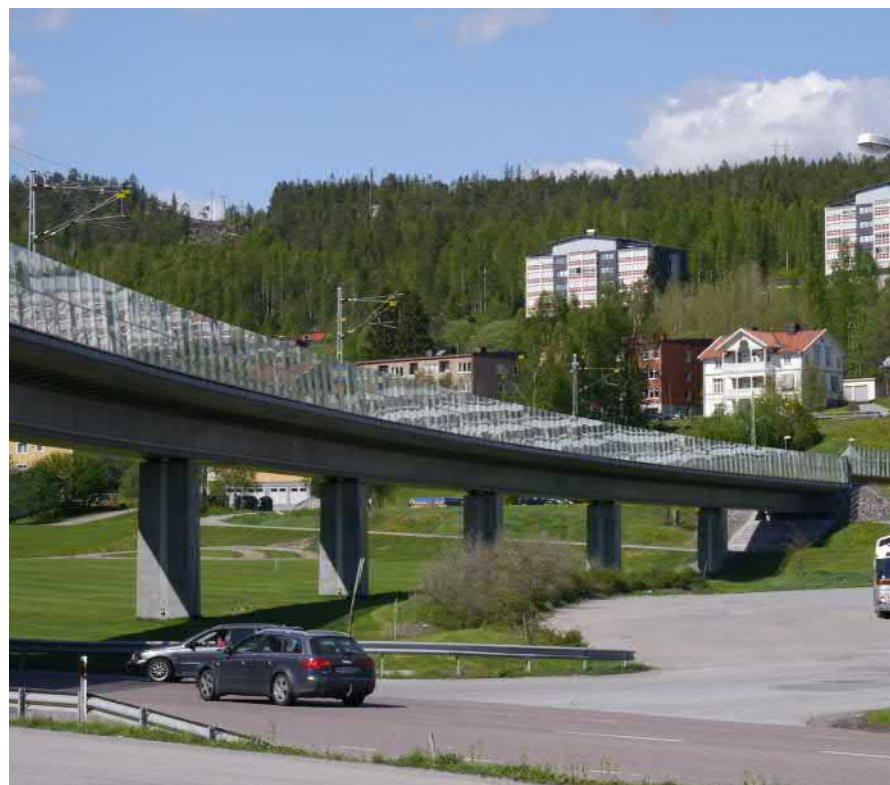
Figur 4-17 I tätortsmiljö bör transparenta bullerskydd övervägas. Botniabanan, Örnsköldsvik. Foto: Landskapslaget
