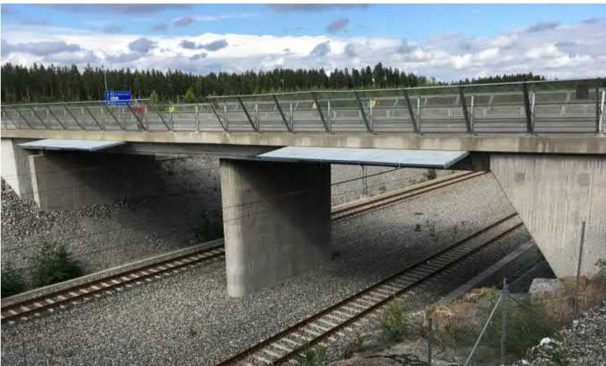
Figur 4-25 Broräcken och elskydd för bro över järnväg (Nordmaling). Foto: Landskapslaget
