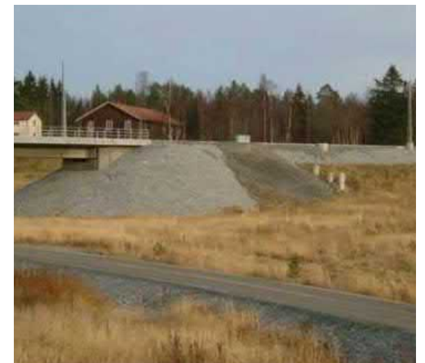
Figur 4-23 Banken har täckts med yttjord och smälter in i landskapet. Brokonen som ej täckts bryter av. Botniabanan. Bild ur GP 2011
