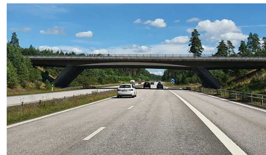
Figur 5-21 Alternativ brotyp som studerats för bro över E4:an: balkram tre spann (snedbenning) Foto: Landskapslaget
