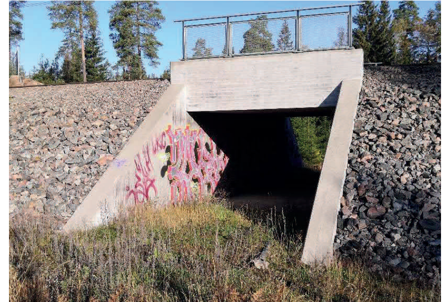
Figur 5-11 Referensbild utformning av vilt- och skoterport. Till vänster grön banvall och bantrumma för vattendrag. Källa Dahlgencs cement. Till höger ett exempel för skoter. Istället för sprängsten är det önskvärt med ett finmaterial som täcker slänterna. Källa PM Passageplan
