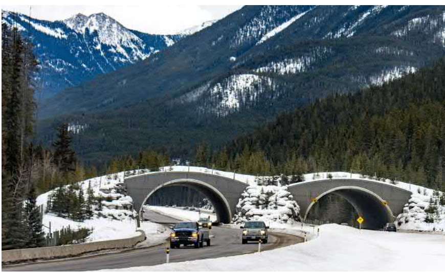
Figur 4-13 Exempel på accentuerad tunnelmynning. Banff park Kanada Källa: Wikimedia commons
