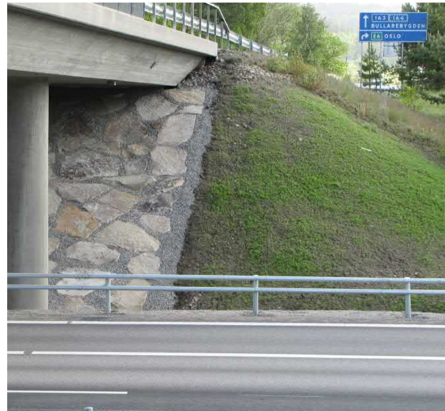
Figur 5-5 Glacis under bro av ordnad sprängsten. Foto: Landskapslaget
