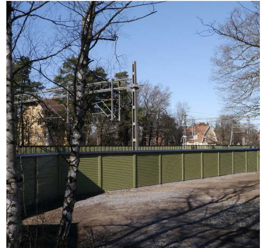
Figur 4-16 Exempel på bullerplank i trä, Roslagsbanan. Foto: Landskapslaget
