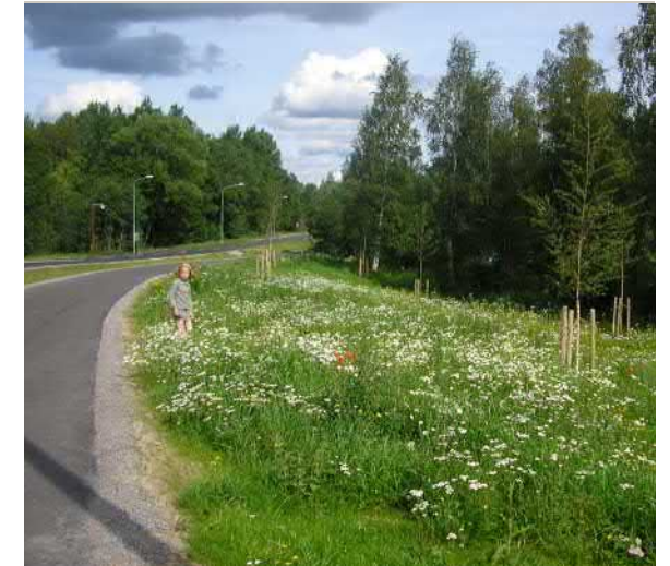
Figur 4-21 Vägslänt med insädd av ängsfröblandning och planterad tall. Foto Annica Forsberg, Tyrens AB
