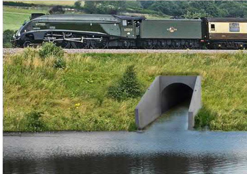
Figur 5-11 Referensbild utformning av vilt- och skoterport. Till vänster grön banvall och bantrumma för vattendrag. Källa Dahlgencs cement. Till höger ett exempel för skoter. Istället för sprängsten är det önskvärt med ett finmaterial som täcker slänterna. Källa PM Passageplan
