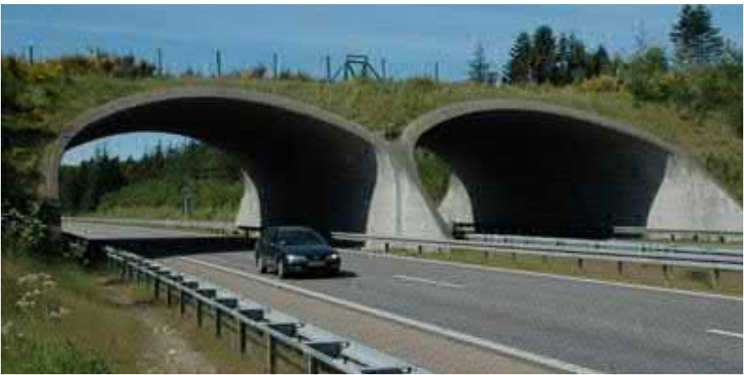
Figur 4-12 Exempel bearbetad tunnelmynning som blir en del av landskapsformen Källa: Wikimedia commons
