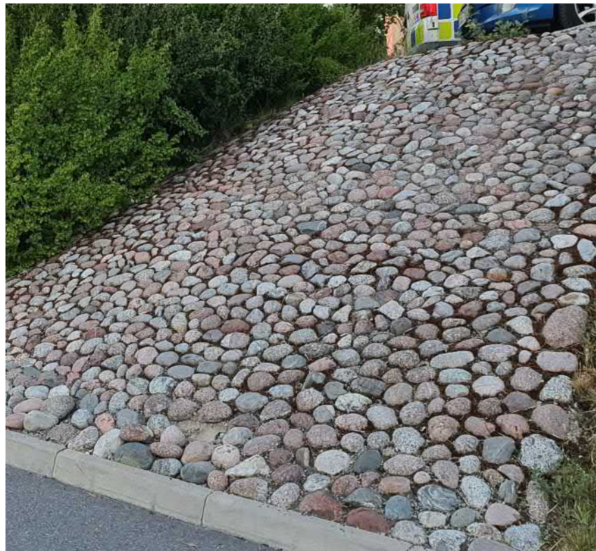
Figur 5-4 Stenskodd slänt (glacis) av kullersten. Foto: Landskapslaget
