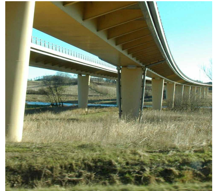
Figur 5-6 Bearbetade runda bropelare, Tranarpsbron. Foto: Bengt Schibbye
