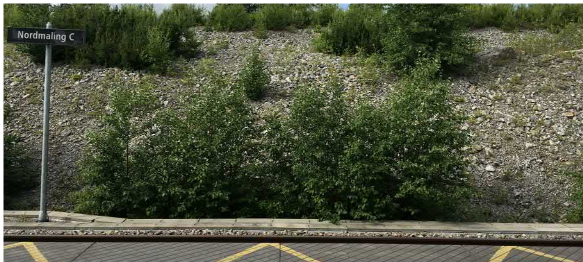
Figur 4-22 Exempel på hur krosslänter blir grogrund för massiva svårskötta slyupplag. Därför ska slänter i exponerade lägen och tätortsmiljö täckas med naturligt bildad jord se vidare avsnit 4.1.3. Botniabanan, Nordmaling. Foto: Landskapslaget
