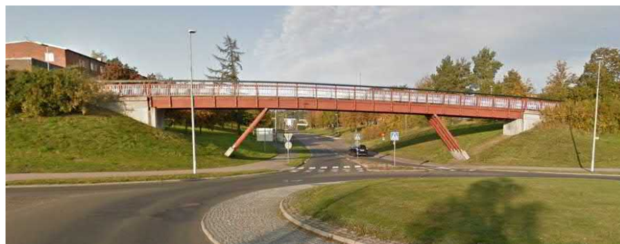
Figur 5-45 Referens, bro över Nohlagavägen i Skövde. Foto: Google maps
