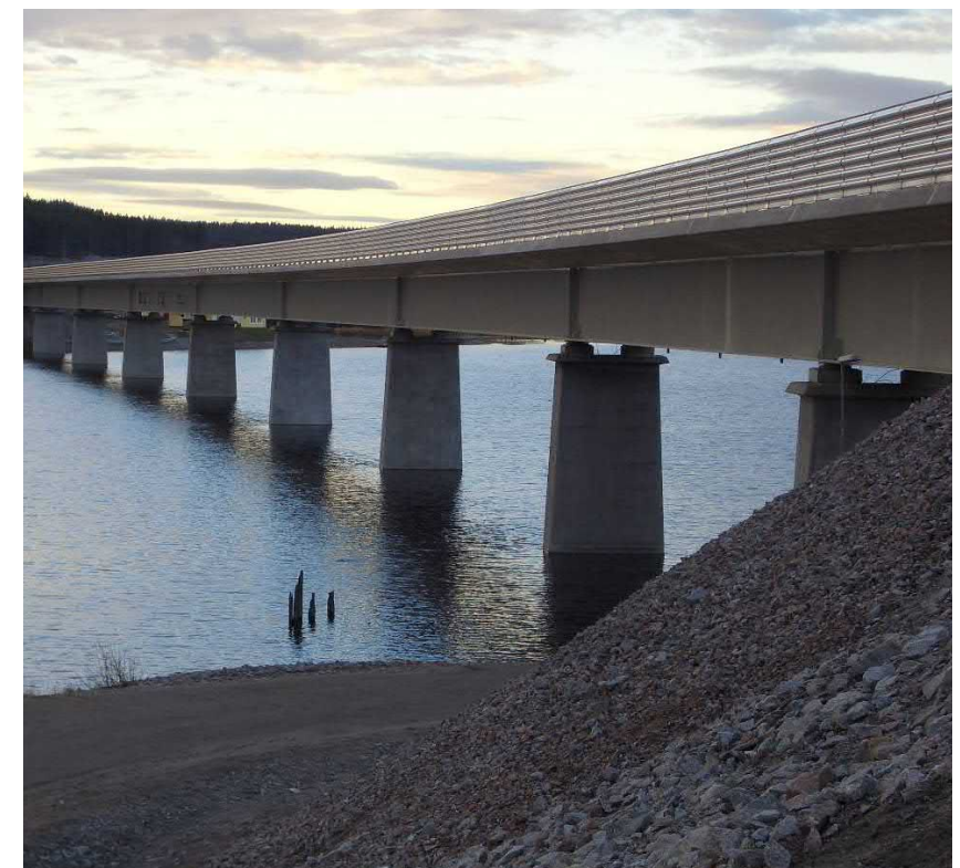
Figur 4-18 Bullerskydd med sinuskurva av metall, bro över Veckefjärden, Botniabanan. Foto: Landskapslaget
