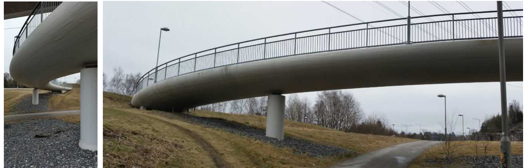
Figur 5.-43 Referens: Gång- och cykelbro i förlängning av Esbogatan, Kista. Bron utformad med en mjukt välvd tvärsektion med en elliptisk profil. Det ger ett bearbetat element i infrastrukturlandskapet och spelar med form och ljus/skugga. Landmärke
