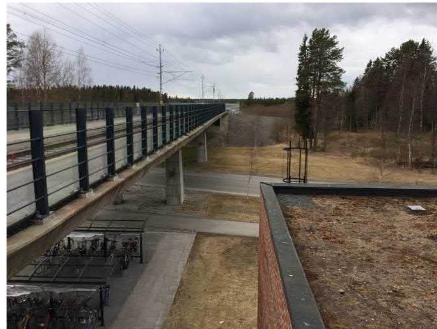
Figur 4-7 I flacka landskap bör passager om möjligt läggas under järnvägen. Foto Britta Pedersen
