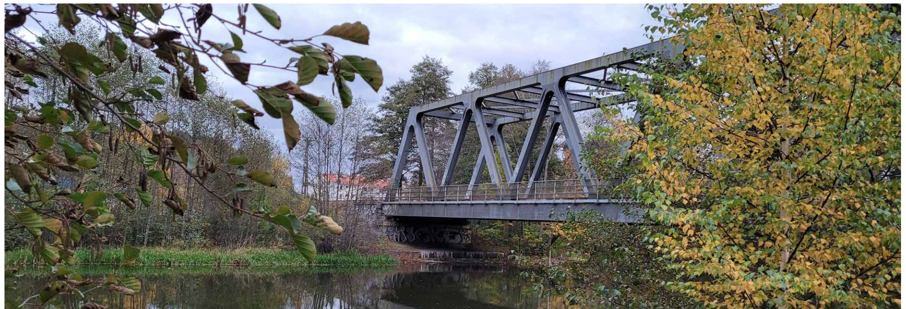
Figur 53. Befintlig järnvägsbro över Nyköpingsån och plats för passage under bron, fotograferad från västra sidan ån.
