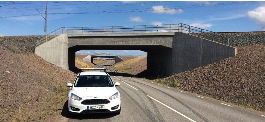
Figur 17. Exempel på järnvägsbro över väg i form av en plattrambro med vingmurar.
