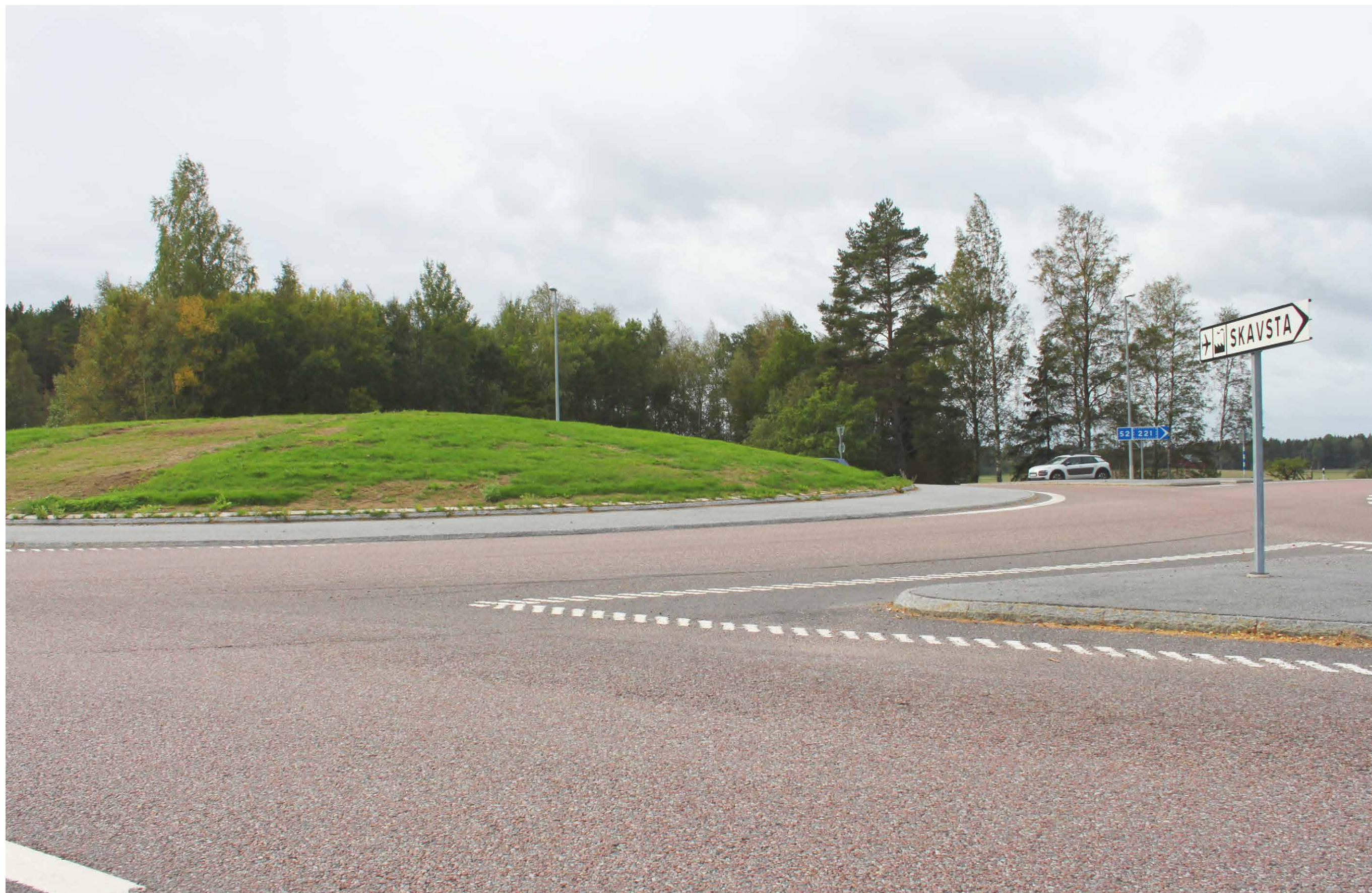
Figur 26 Rondell som kopplar samman väg 52 med väg 629 som går till Skavsta flygplats
